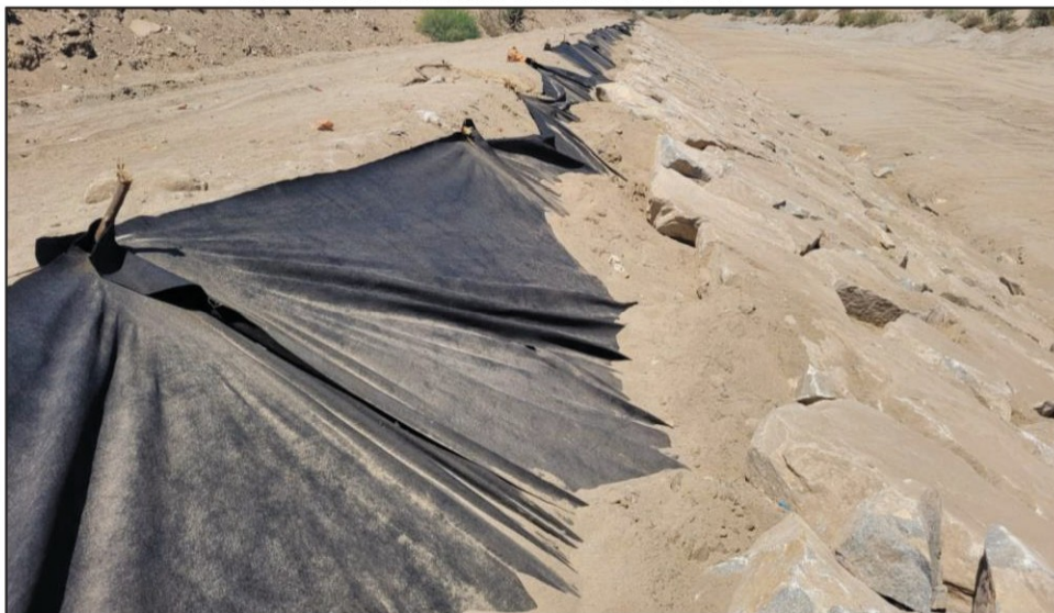
Imagen n.º9 Colocación de malla Geotextil en obra
