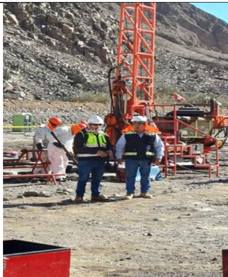
Imagen N° 9. Personal técnico que realiza trabajos de perforación para tratamiento de impermeabilización, no cuenta con Lentes de Seguridad
