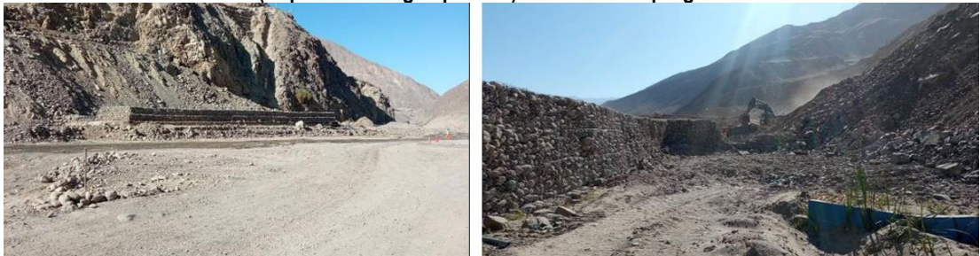
Imagen N° 4 y 5 Galería filtrante (Captación de agua potable) ubicada en la progresiva 0+420
