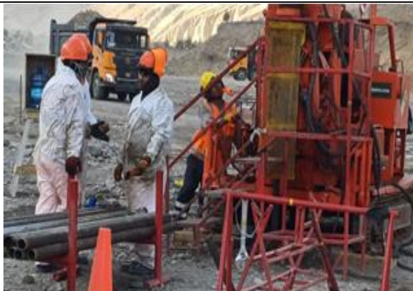
Imagen N° 9. Personal técnico que realiza trabajos de perforación para tratamiento de impermeabilización, no cuenta con Lentes de Seguridad
