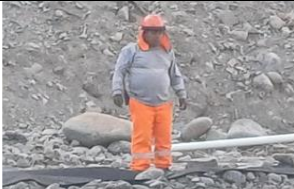
Imagen N° 8. Personal que realiza trabajos de perforación para tratamiento de impermeabilización, no cuenta con Lentes de Seguridad
