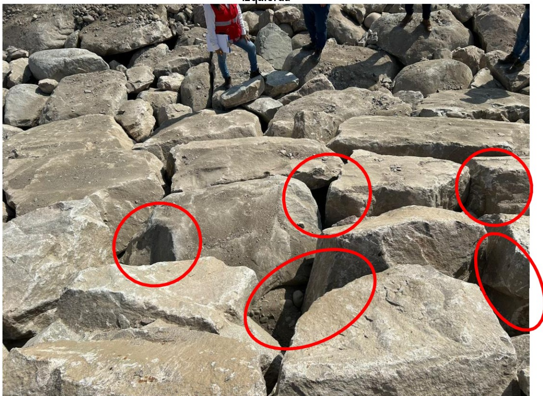
Imagen n.º 21 Separaciones entre el material que conforma el enrocado de los taludes del Sector Chico 01 margen izquierda
