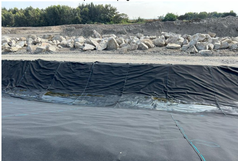
Imagen n.º 25 Vista del manto Geotextil (Lado Uña) en la margen izquierda del río en el sector Chico 01 con presencia de pliegues.
