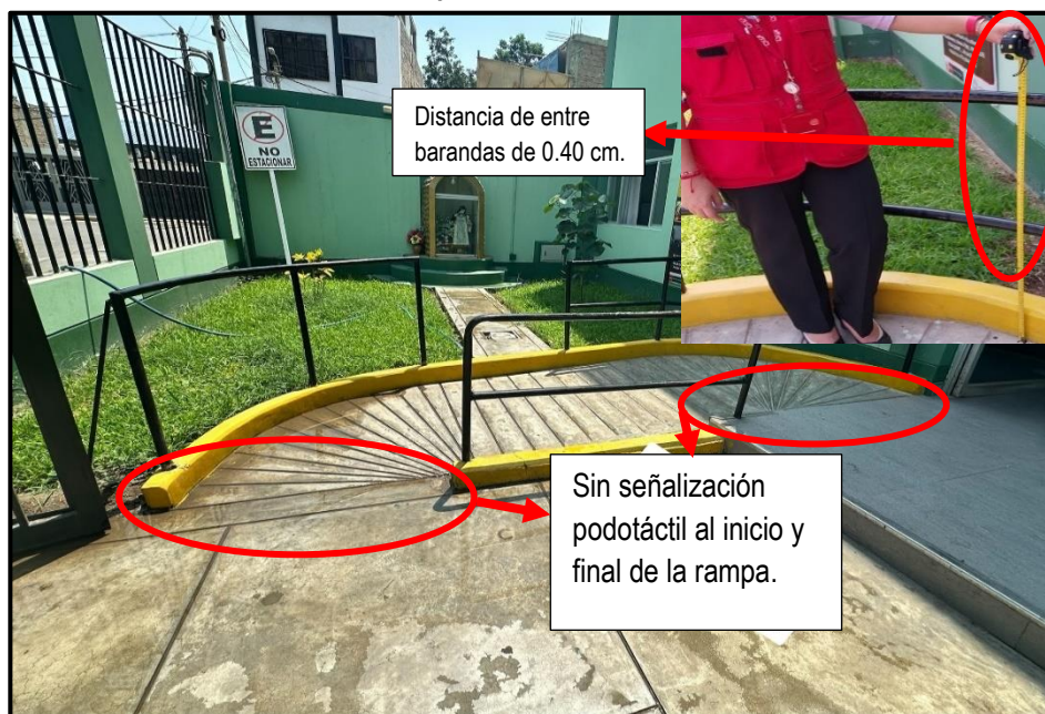
Imagen n.º 6 Rampa de acceso a la comisaría
