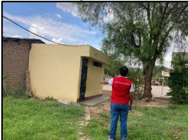
Imagen n.º 11 Unico modulo de servicios higiénicos existente en Institución Educativa
