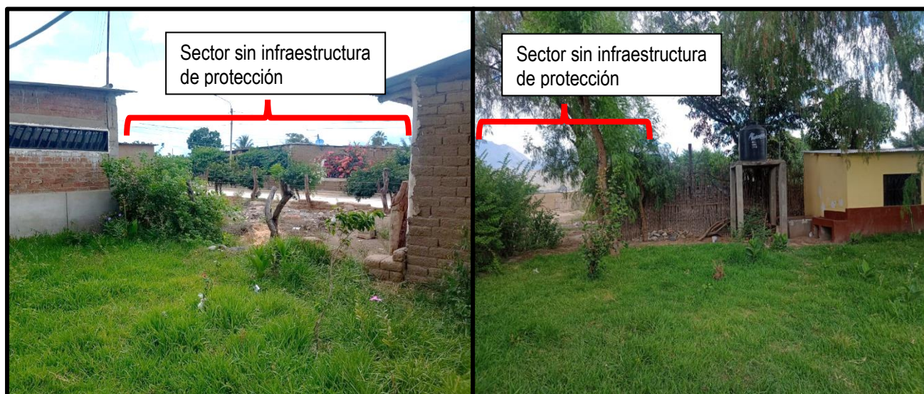
Imágenes n.°s 5 y 6 Institución Educativa carece de cerco perimétrico en zonas laterales y posterior
