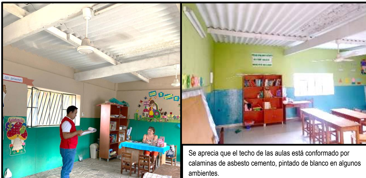
Imágenes n.ºs 7 y 8 Cobertura de Techo de aulas
