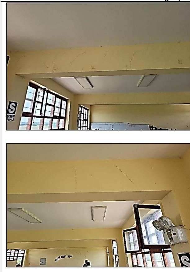
En las imágenes se observa que las vigas peraltadas de los techos de las edificaciones que comprenden el tercer piso del módulo de nivel secundario, presentan fisuras, ubicadas en la zona de confinamiento de las vigas, en todas las vigas de los pórticos del nivel de piso antes indicado; los cuales deben ser evaluadas y de ser el caso corregidas, a fin de garantizar su operatividad, permitiendo contribuir en el control de los esfuerzos y desplazamientos de la edificación, ante un posible sismo.
