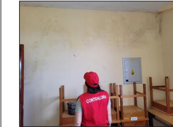
En la imagen se observa muros afectados con presencia de humedad, esto debido a que en la parte superior de los muros (techo) de los encuentros entre las edificaciones, donde se ubican las juntas de construcción (separación entre las edificaciones), no estuvo protegida con elementos que eviten el ingreso de agua de lluvia, situación que ocasiono la acumulación de agua entre ambos lados de la edificación.
