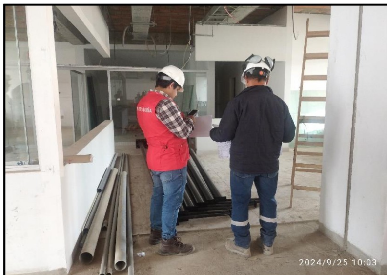
FOTOGRAFÍA N° 6 ALMACENAMIENTO DE TUBERÍA METÁLICA EN ÁREAS DE TRABAJO
