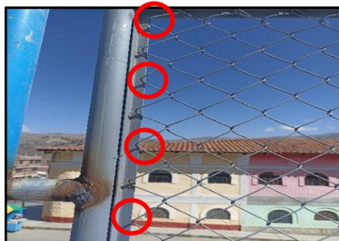
IMAGEN N° 9 VISTA DE TIJERAL CON ACERO GALVANIZADO DEFORMADO Y MALLA OLÍMPICA NO SOLDADO EN TODO EL MARCO
