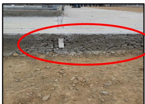
IMAGEN N° 11 VISTA DE PERNO CHUECO Y CONCRETO SEGREGADO EN VEREDA
