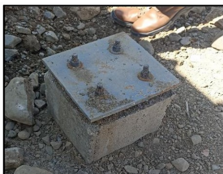
IMAGEN N° 11 VISTA DE PERNO CHUECO Y CONCRETO SEGREGADO EN VEREDA
