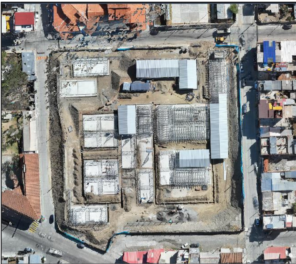
Fuente: Fotografía tomada con DRON durante la inspección de obra de 28 de junio de 2024.
