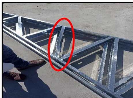
IMAGEN N° 9 VISTA DE TIJERAL CON ACERO GALVANIZADO DEFORMADO Y MALLA OLÍMPICA NO SOLDADO EN TODO EL MARCO
