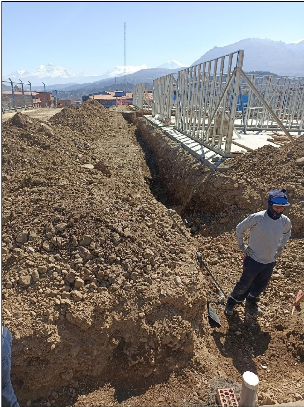
Fuente: Fotografía tomada con DRON, durante la inspección de obra de 28 de junio de 2024.
