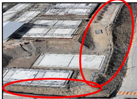
IMAGEN N° 10 VISTA DE LAS CIMENTACIONES DEL CERCO PERIMÉTRICO DE MALLA OLÍMPICA, EL CUAL SE HA CIMENTADO SOBRE MATERIAL DE RELLENO MUY CERCANO AL TALUD, SIN TRATAMIENTO PREVIO
