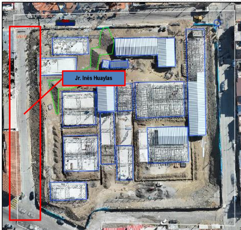
FOTOGRAFÍA N° 14 SE VERIFICA MATERIAL EXCEDENTE PRODUCTO DE LA EXCAVACIÓN EN JR. INÉS HUAYLAS
