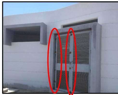
En la fotografía n.º 1 podemos observar que la rejilla de la carcasa está claramente con signos de corrosión producto de la exposición al medio ambiente, también en la fotografía n.º 2 se observa que la puerta metálica de la sub estación n.º 4, tiene signos de corrosión producto de la aplicación de la soldadura, en vista que ha quemado la pintura, adicionado a esto la exposición al medio ambiente.
