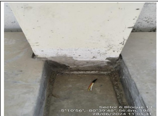
Fotografía n.º 8: Bancos de concreto tarrajeados.
