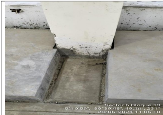
Fotografía n.º 7: Bancos de concreto tarrajeados.
