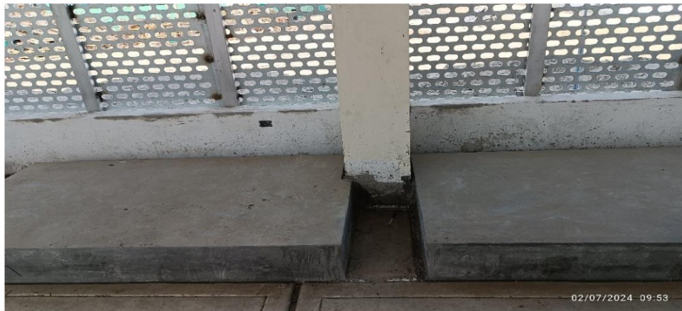
Fotografía n.º 9: Bancos de concreto tarrajeados, en intersección con la columna C-4.
