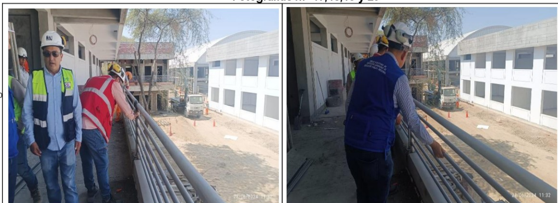
Fotografía n.º 17: Verificación de vibración de travesaños de baranda metálica.
