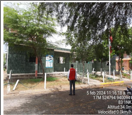
Fotografía n.° 2: Se aprecia el límite de la Comisaría.
