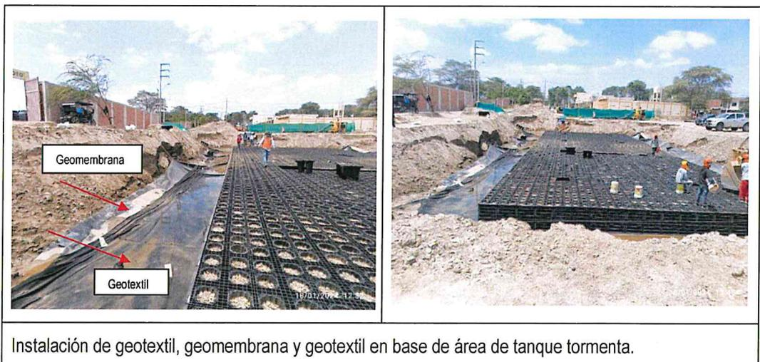
Instalación de geotextil, geomembrana y geotextil en base de área de tanque tormenta.
