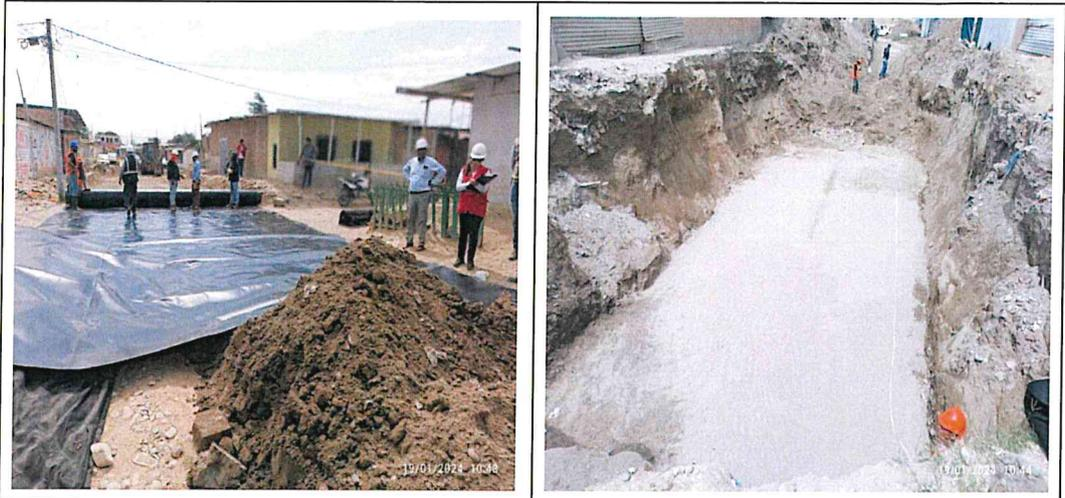
Extendido de geomembrana y área donde se instalaría el tanque tormenta.
