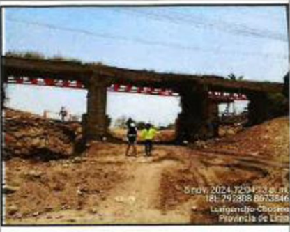
Foto 4: Vista hacia aguas abajo en dirección del "badén" Canoas, se aprecia estructura metálica temporal para el desvío del acueducto.
