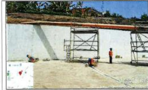
Foto 7: Vertimiento entubado que no cuenta con buzón ni ducto de ingreso al canal en la progresiva 4+656 (paquete 4.2).
