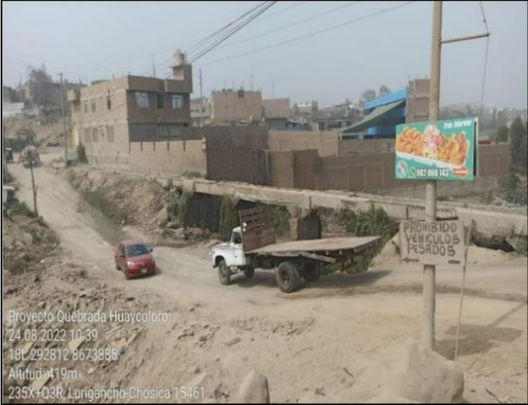
Imagen N° 6 Ubicación del cruce vehicular N° 2
