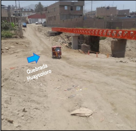
Foto N° 10: Vista panorámica de Acueducto N° 1, 6+370, perteneciente al paquete 4.3A.
