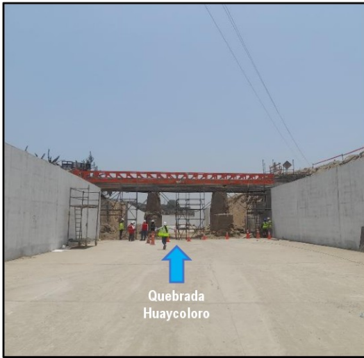
Foto N° 12: Vista panorámica de Acueducto N° 2, 7+250, perteneciente al paquete 4.3B.
