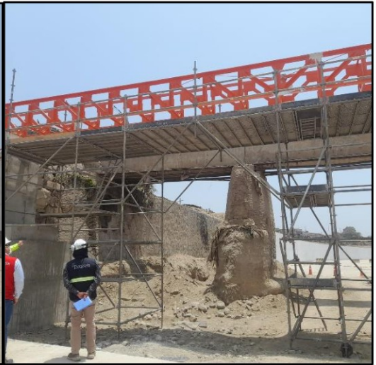
Foto N° 13: Puente Bailey provisional del acueducto N° 2.
