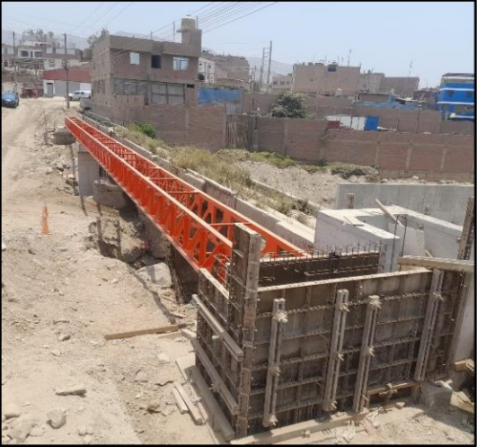
Foto N° 11: Bailey provisional del acueducto N° 1.
