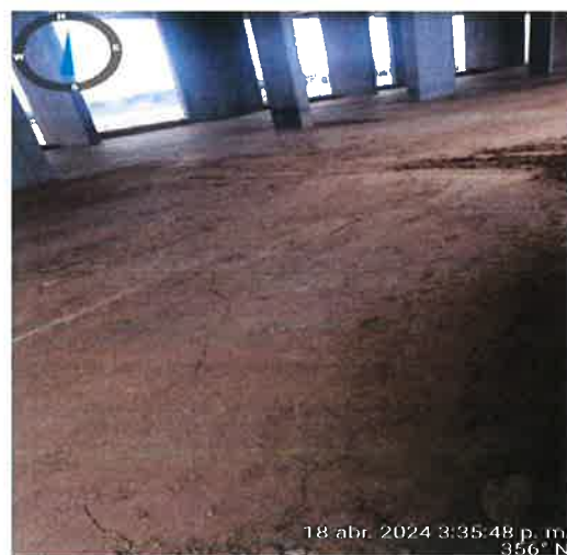
Fotografía n° 13. Fisuras en el relleno conformado del primer nivel del dique Norte.
