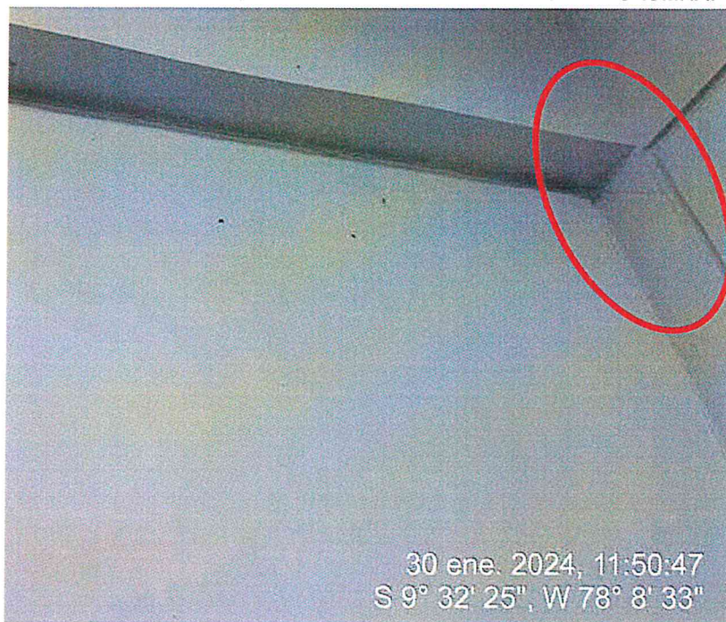
IMAGEN 2 FISURA EN JUNTA QUE PROLONGA AL TARRAJEO DE COLUMNA.
