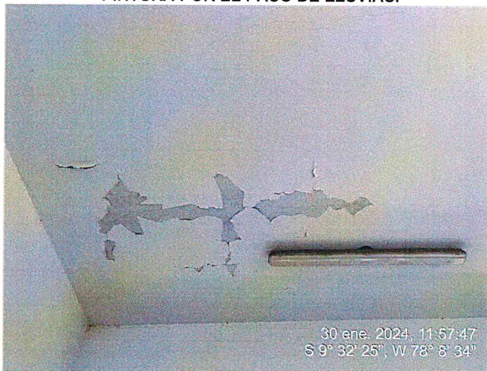
IMAGEN 14 FISURA EN TECHO CON DESPRENDIMIENTO DE PINTURA POR EL PASO DE LLUVIAS.
