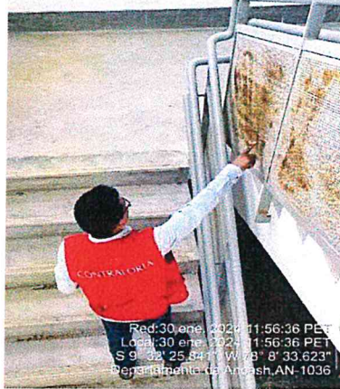
IMAGEN 18 TAPAS DE LAS BARANDA OXIDADAS
