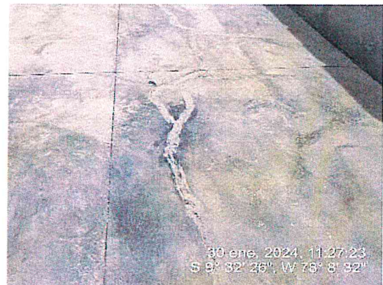
IMAGEN 19 FISURAS EN LOS PISOS DEL PATIO DE INGRESO
