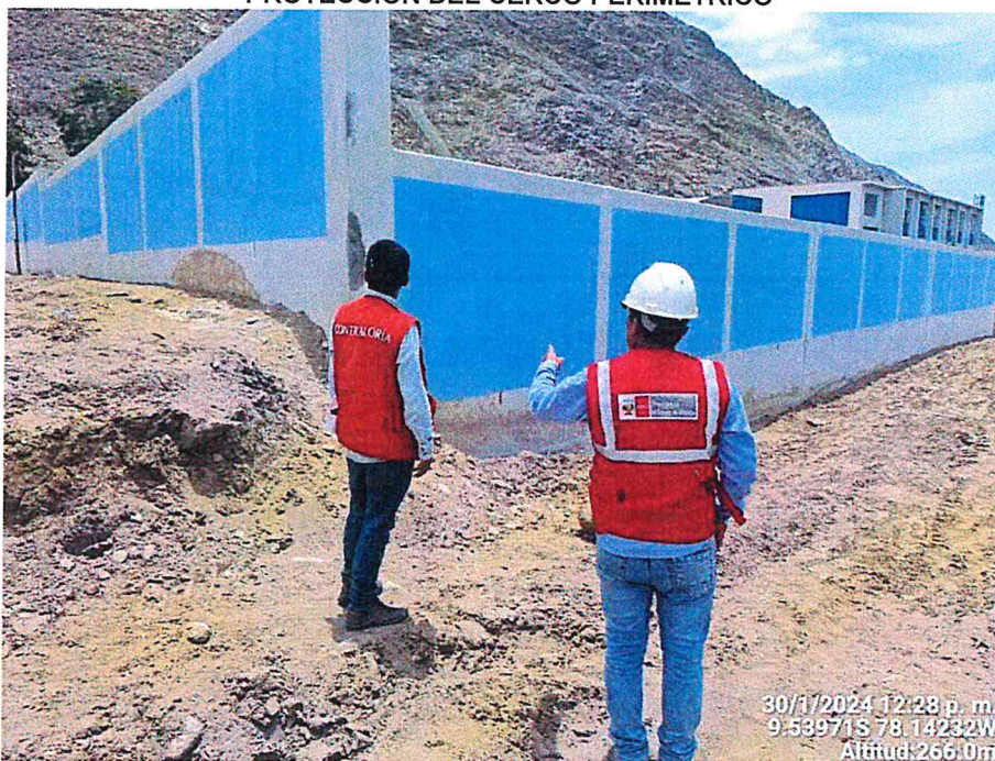
IMAGEN 12 TRABAJOS COMPLEMENTARIOS DE CALZADURA PARA PROTECCIÓN DEL CERCO PERIMÉTRICO
