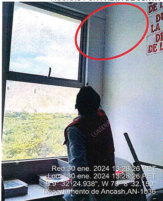
IMAGEN 3 FISURAS POR FALTA DE JUNTA QUE PROLONGA AL TARRAJEO DE MURO.
