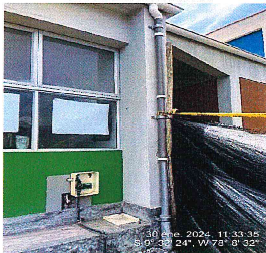
IMAGEN 1 BAJADA PLUVIAL DE TUBERÍA DE PVC SIN PINTURA DE PROTECCIÓN SOLAR
