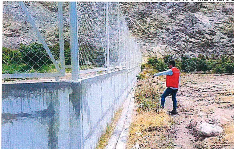
IMAGEN 11 ACABADO RUSTICO EN SOBRECIMIENTO DE CERCO METALICO
