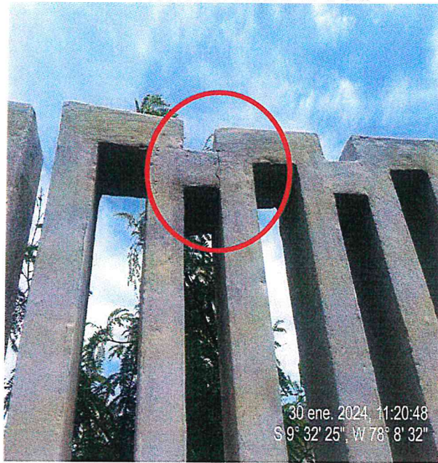
IMAGEN 9 FISURA EN CERCO TIPO UNI
