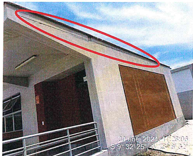
IMAGEN 5 FISURA POR FALTA DE JUNTA QUE PROLONGA AL TARRAJEO DE MURO
