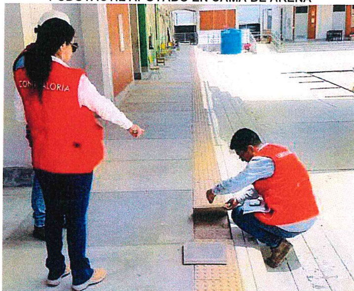
IMAGEN 10 PODOTÁCTIL APOYADO EN CAMA DE ARENA
