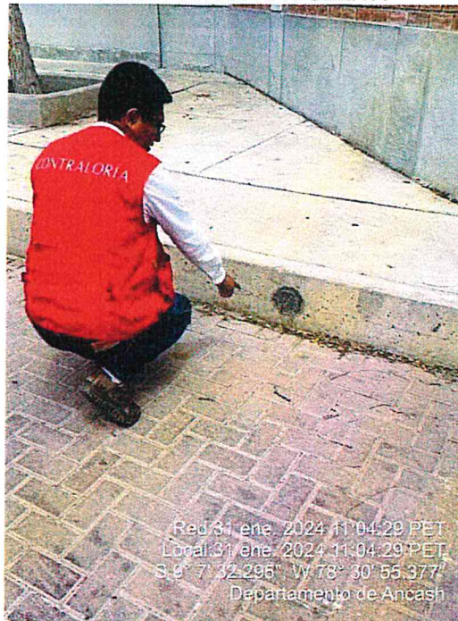
IMAGEN 11 SALIDA DE DRENAJE PLUVIAL DIRECTO A LA VIA PUBLICA
