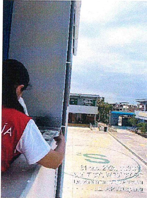
IMAGEN 12 TUBERIA DE PVC SIN PINTURA DE PROTECCIÓN SOLAR EN BAJADA PLUVIAL
