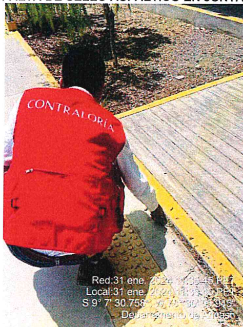
IMAGEN 13 FALTA DE SELLO ASFALTICO EN JUNTAS
