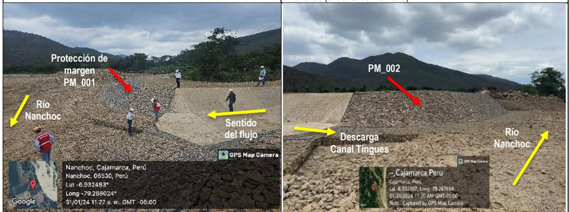
**Foto N° 9:** Protección de margen en la entrega del canal de descarga al río Nanchoc (PM\_001).
