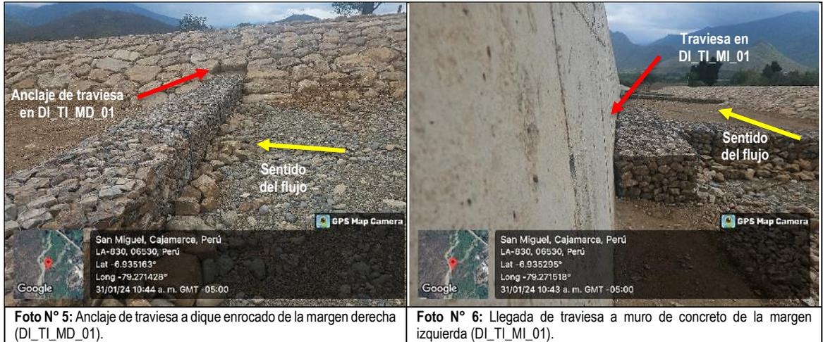
**Foto N° 5:** Anclaje de traviesa a dique enrocado de la margen derecha (DI\_TI\_MD\_01).
