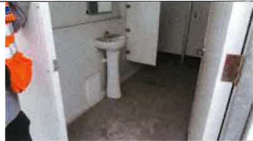
Fotografía N° 13: Vista de uno de los Servicios Higienicos de Administrativos y Docentes.
