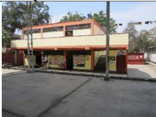
Fotografía N° 2: Vista interna de la institución educativa existente Infraestructura a desmontar y demoler para la construcción de Escuela Permanente.
