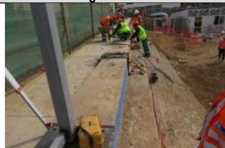
Fotografía N° 4: Vista del vaciado de dados para cimentación de cerco metálico en Jr. 1 de Mayo.
