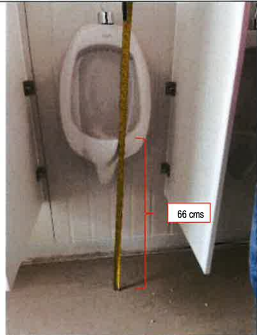
Fotografía N° 17: La Comisión de Contro advirtió que la altura del Urinario de los Sericios Higienicos de varones de Primaria es de 66 cms.
