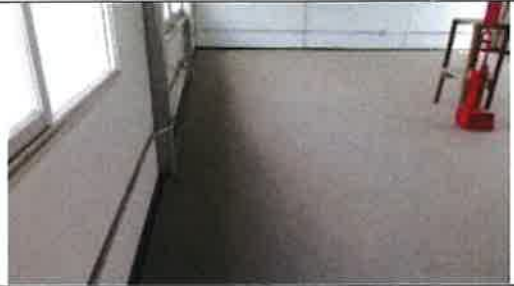
Fotografía N° 14: Vista de los pisos vinilico y contrazocalo instalado en las aulas.
