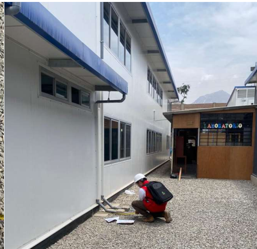
Fotografía N° 26: Vista de tuberías de descarga de drenaje pluvial (Longitud: 70 centímetros).
