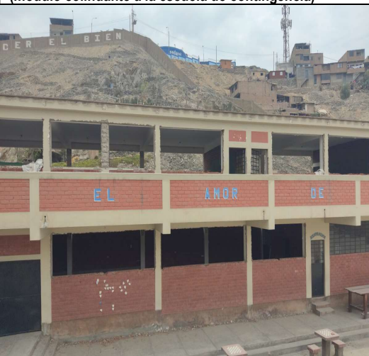
Fotografía N° 4: Vista de la infraestructura a demoler (módulo colindante con terreno de terceros).
