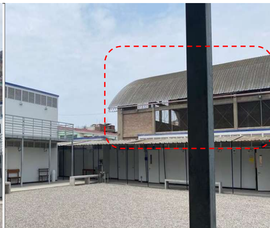
Fotografía N° 8: Vista exterior del polideportivo existente.
