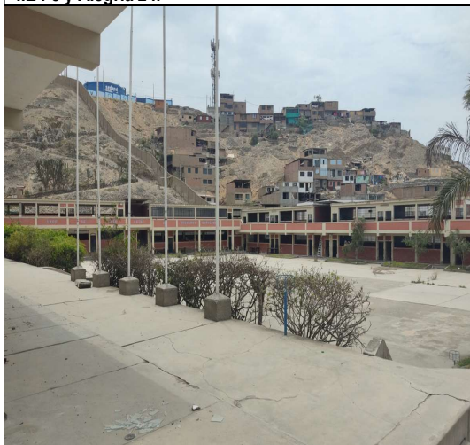
Fotografía N° 3: Vista de la infraestructura a demoler (módulo colindante a la calle Melitón Carbajal).
