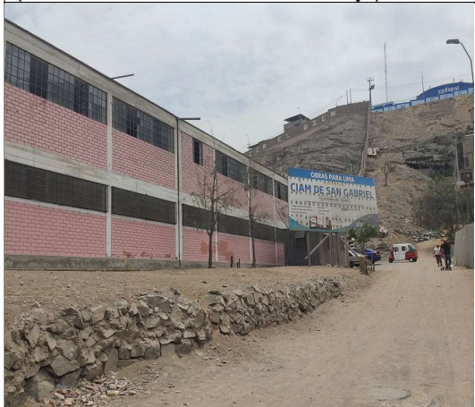
Fotografía N° 5: Vista exterior del cerco perimétrico colindante con la calle Melitón Carbajal.
