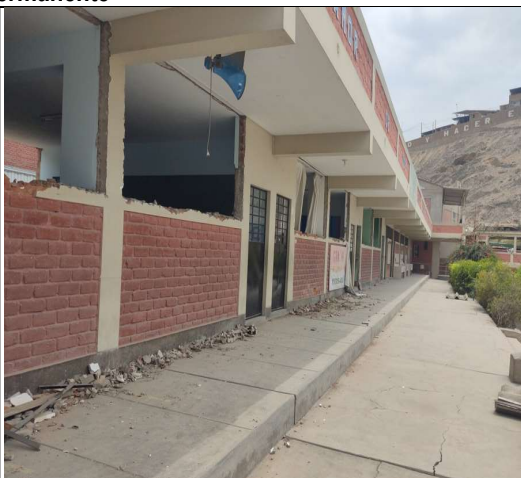
Fotografía N° 2: Vista de la infraestructura a demoler (módulo colindante a la escuela de contingencia)
