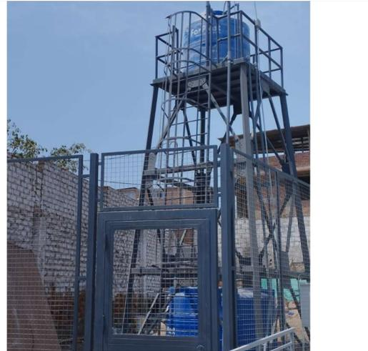
**Fotografía N° 9: Vista tanque elevado (2600 litros) y cisterna (5000 litros) para el abastecimiento de agua.**
