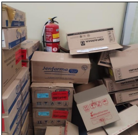
Imagen n.º 6 Acceso al extintor
