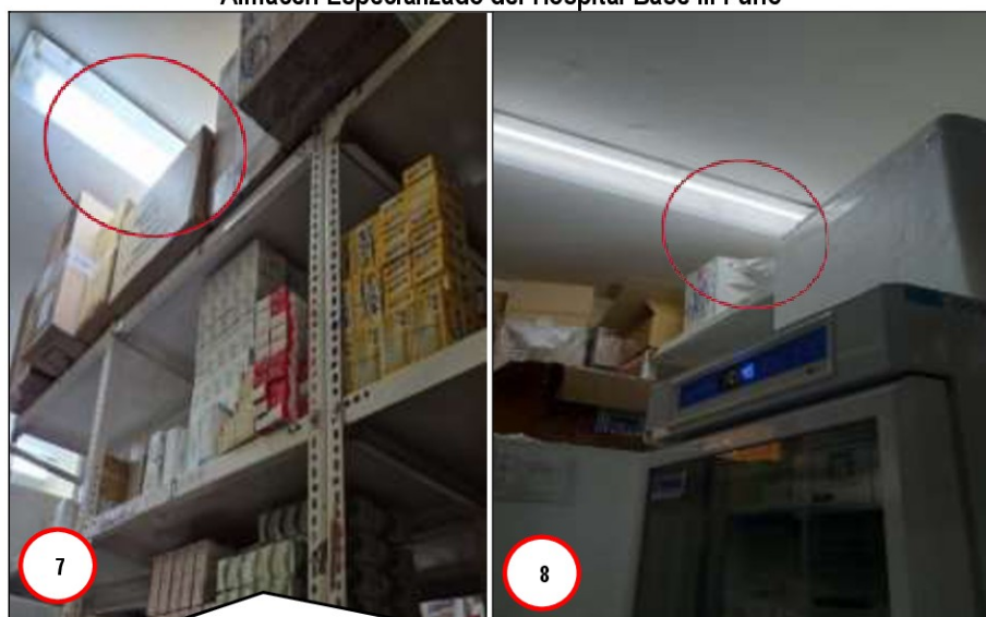
Imagen n.º 4 Almacén Especializado del Hospital Base III Puno
