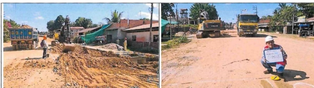
Trabajos de movimiento de tierras para la conformación de la subrasante de pavimento rígido de concreto armado
