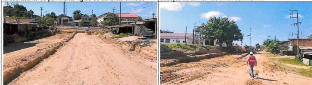
Km 00+070 Conformación de subrasante para el pavimento rígido de concreto armado
