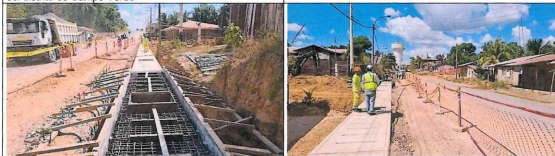
Encontrado de alcantarillas laterales a la zona de pavimento rígido, en la zona urbana del distrito de Campo Verde
