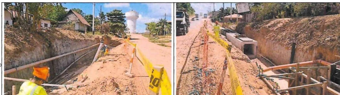
Colocación de acero de refuerzo para las alcantarillas laterales a la zona de pavimento rígido, en la zona urbana del distrito de Campo Verde
