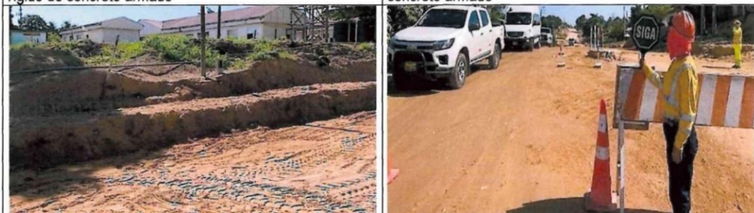
Trabajos de movimiento de tierras para la conformación de la subrasante de pavimento rígido de concreto armado
