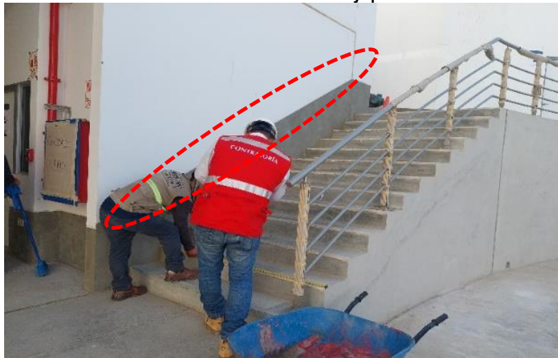
Imagen N° 04 – Escalera 8 ubicada en Patio de central de Gases y que da acceso a área de Cisternas
