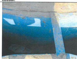
Detalle del canal Pashall se observa que no cuenta con el sistema de medición del caudal.
