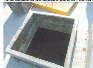
Interior de la cisterna de agua para regadío del cerco vivo.
