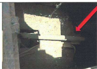
Interior de la caja de conexiones domiciliaria del domicilio Mz P° lote 4, no tiene la válvula auxiliar de 1/2\".
