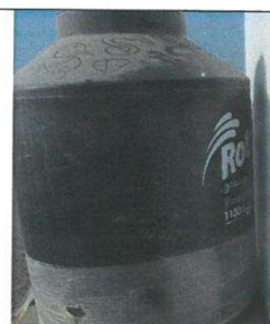
Detalle del tanque de 1100 lt de capacidad.
