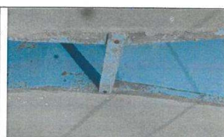
Detalle del canal Pashall se observa que no cuenta con el sistema de medición del caudal.
