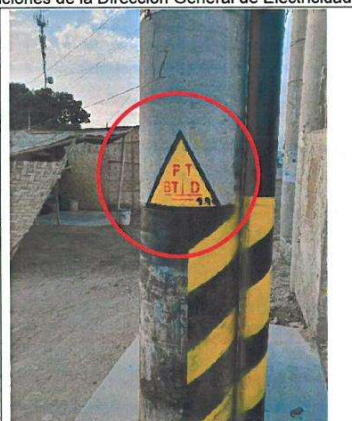
Símbolo e indicación de separación de puesta a tierra debe cumplir Código Nacional de Electricidad.
