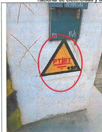
Símbolo e indicación de separación de puesta a tierra debe cumplir Código Nacional de Electricidad.
