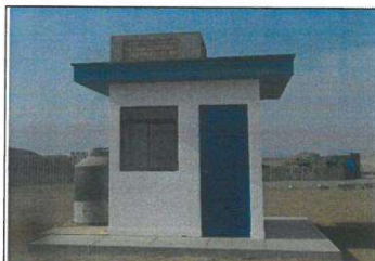
Tanque de agua que falta instalar en el techo con sus respectivos accesorios.
