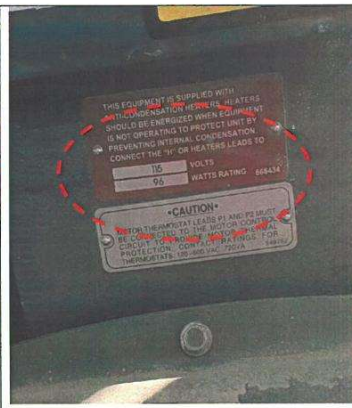
Placa de características de operación de cajuela con resistencia de control de humedad – opera a 115 voltios
