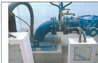
Pozo PP-02 se encuentra con sello sanitario
