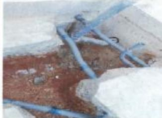
Se verificó el uso de tabiquería de planchas secas de fibrocemento y fibrosilicato en los lavatorios del área de emergencia, material que no corresponde al uso sanitario. Adicionalmente, se visualiza el uso de soportes de madera y estructuras con cortes sin continuidad.
