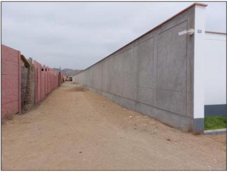
Imagen n.º 26 y 27 Cara exterior de cerco perimétrico sin lijado ni pintado (pasaje S/N), vista de inicio de cerco en Jr. Cuzco (izquierda) y fin en el Jr. Piura (derecha)
