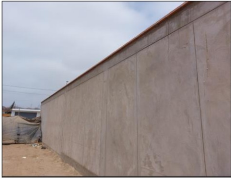
Imagen n.º 26 y 27 Cara exterior de cerco perimétrico sin lijado ni pintado (pasaje S/N), vista de inicio de cerco en Jr. Cuzco (izquierda) y fin en el Jr. Piura (derecha)
