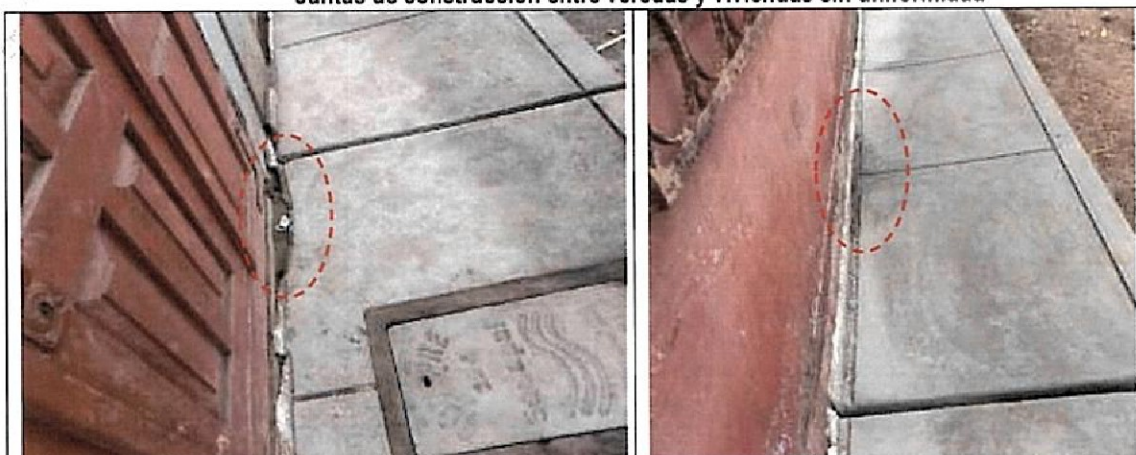
Imagen 25 y 26 Juntas de construcción entre veredas y viviendas sin uniformidad
