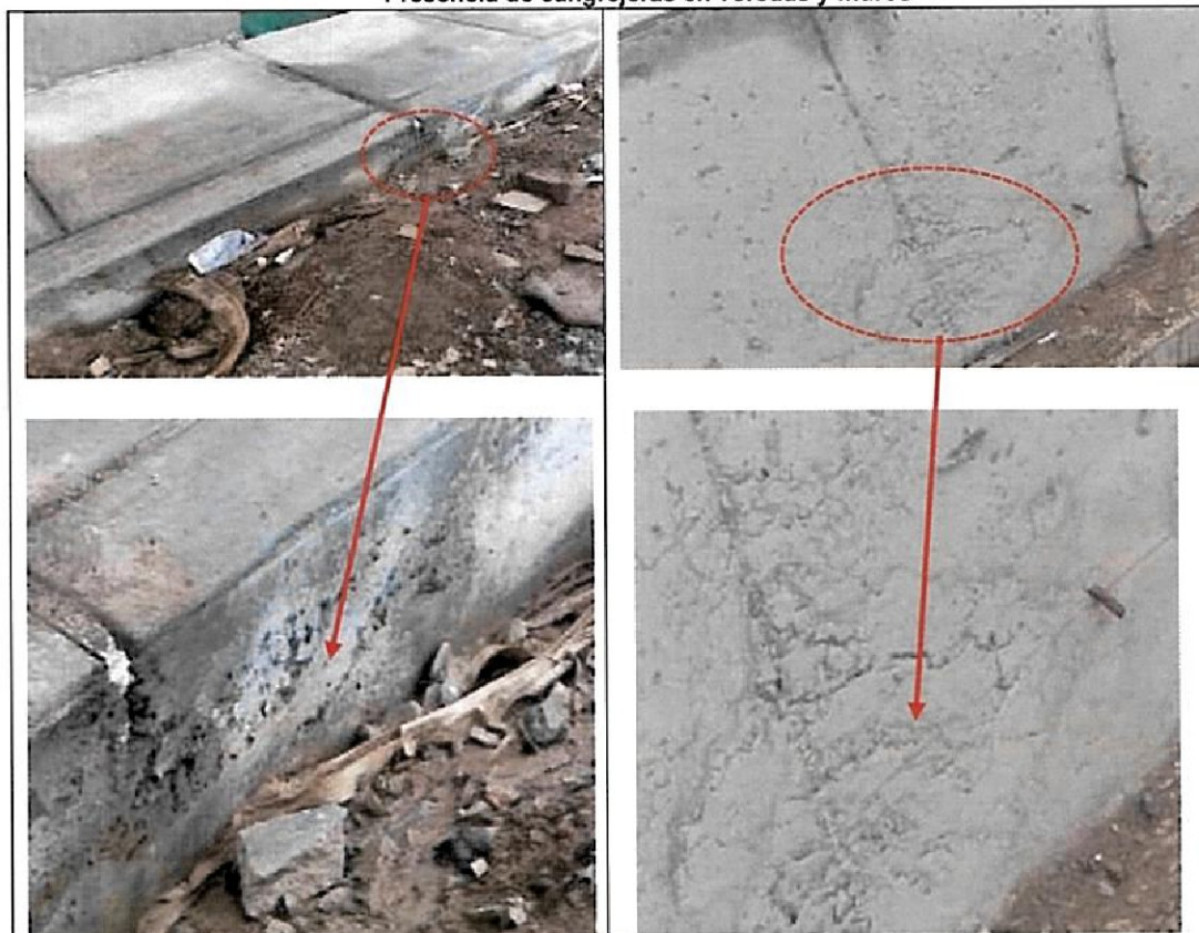
Imagen 23 y 24 Presencia de cangrejas en veredas y muros
