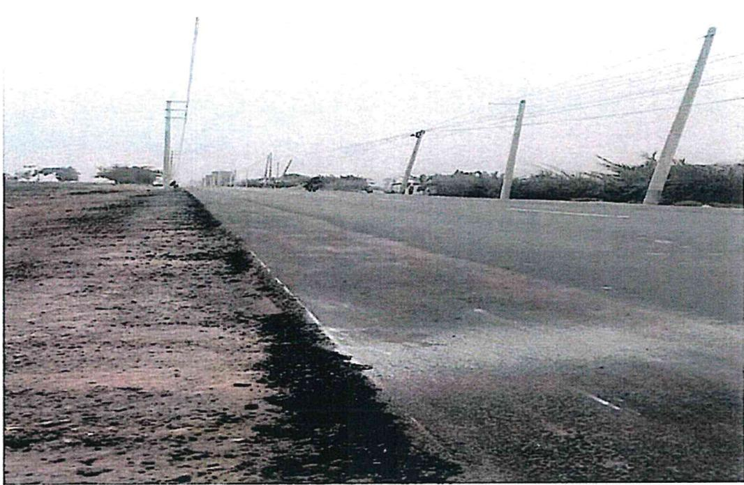
Además, se constató que desde la progresiva 0+650 hasta 0+855 falta carpeta asfáltica en el margen izquierdo de la vía en un ancho de 0.50m.
