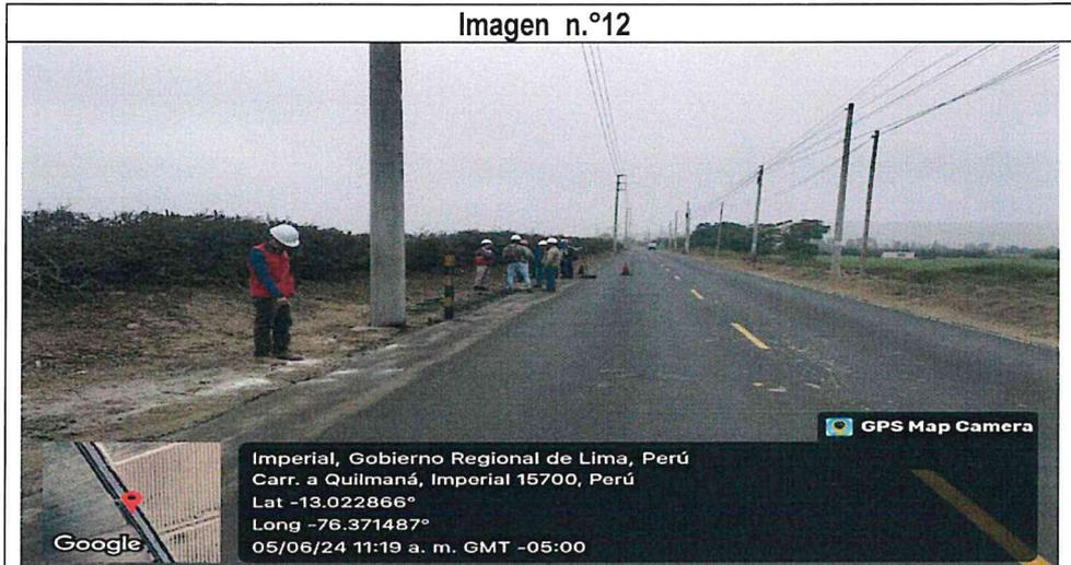
En la progresiva 1+150.00 margen derecho se encontró al personal de obra realizando trabajos de perfilado y compactado de carpeta asfáltica a lo cual el supervisor indico los siguiente:
