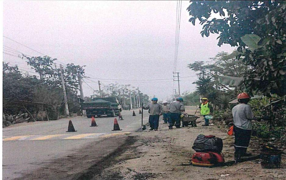
En la progresiva 2+156.00 se encontró otro frente de trabajo con 5 trabajadores, realizando trabajos de compactado de carpeta asfáltica en margen derecho; delimitaron el área de trabajo mediante conos de seguridad como se visualiza en la imagen, de igual manera se les solicito el seguro SCRT del personal de obreros, identificando que dos de ellos no contaban con dicho seguro:
