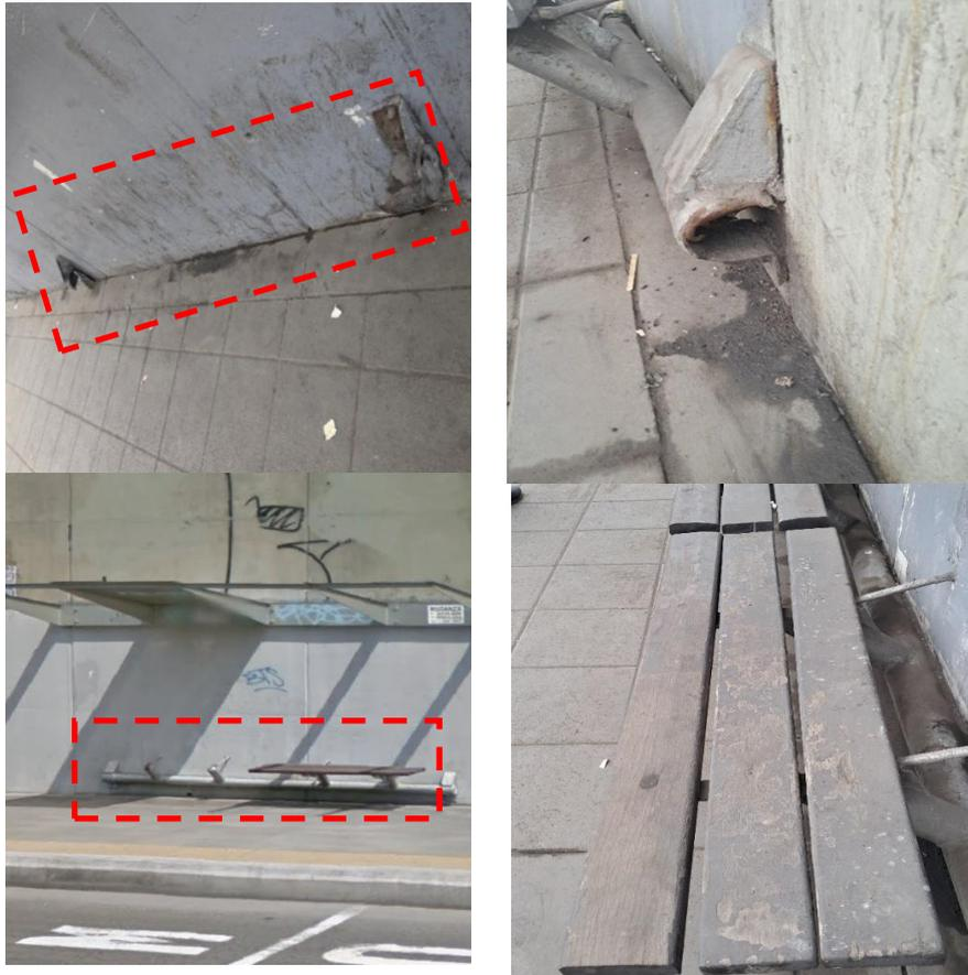
**Fotografías n.ºs 05 y 06:** Estado de las bancas en los paraderos de la vía principal: bancas faltantes, bancas incompletas y bancas deterioradas (con falta de mantenimiento) y llenas de suciedad.
