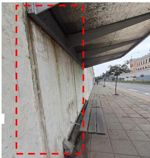
**Fotografías n.ºs 03 y 04:** Diseño de los techos con caída hacia adentro, que provoca que la lluvia y la suciedad discurran hacia los tornillos y acelere el deterioro de los soportes.
