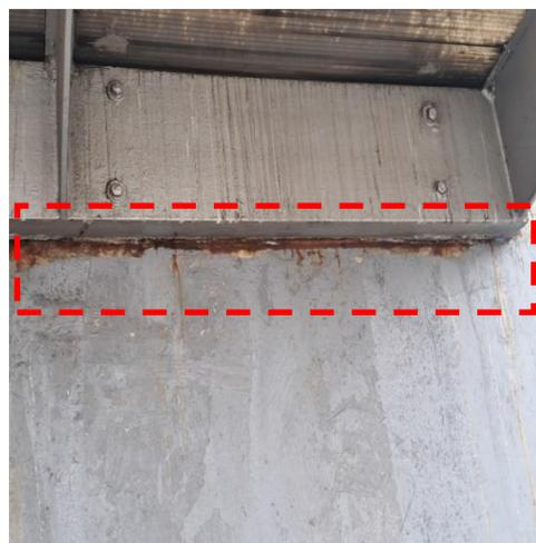
**Fotografías n.ºs 01 y 02:** Estado de corrosión en la parte posterior de la estructura metálica de los techos de los paraderos.
