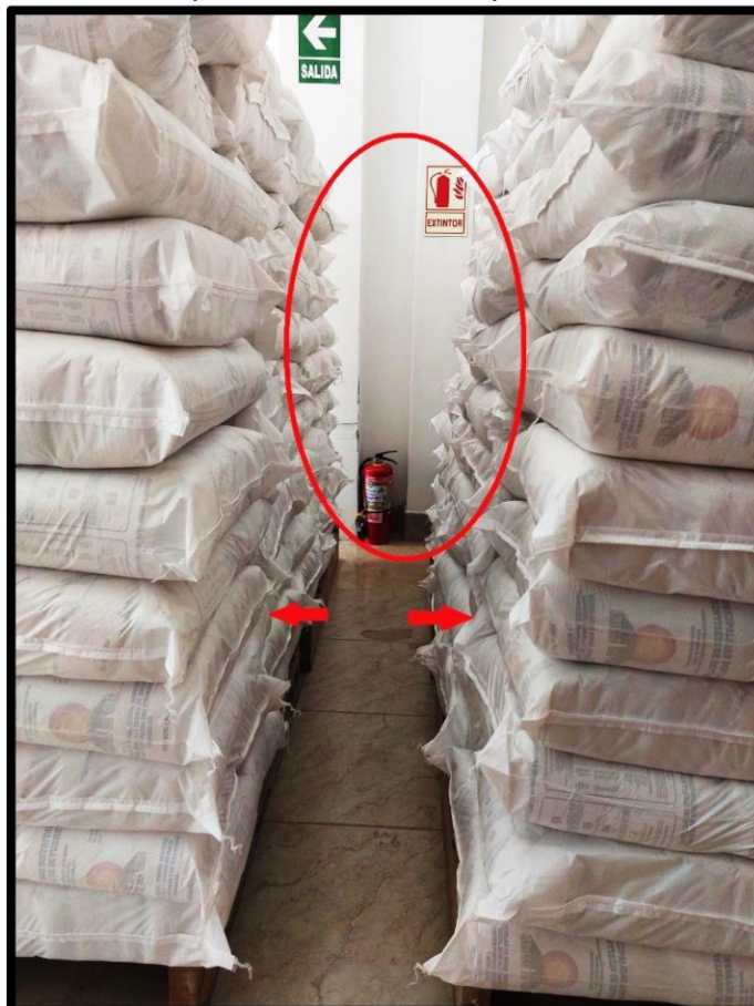
Imagen n.º 15 Extintor del almacén del Programa sin aplicar la norma técnica peruana de los extintores portátiles.
