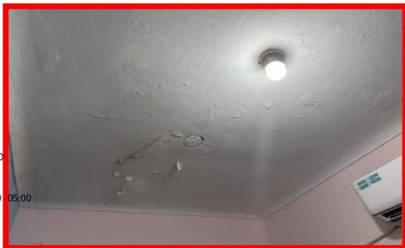
Techo en mal estado y con deficiente iluminación
