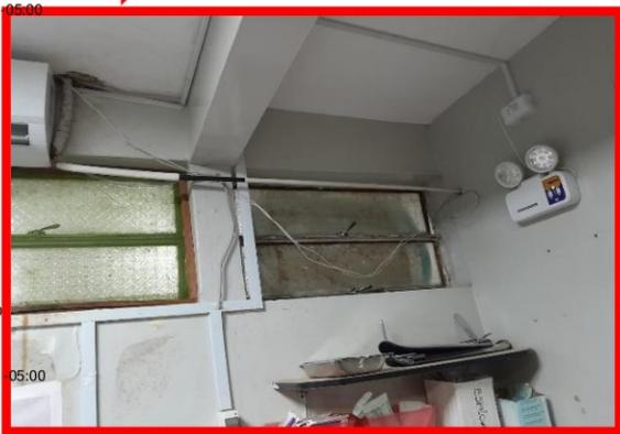
Cables expuestos sin la respectiva canaleta de seguridad
