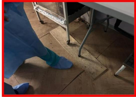
Piso desnivelado de dicha área puede ocasionar accidentes laborales para personal asistencial de dicha área.
