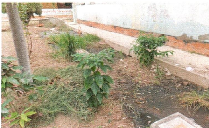
Imagen n.º 11 Presencia de aguas servidas
