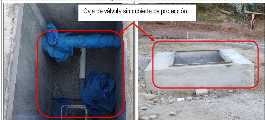
Sector de riego Mendez Yarga, se muestra la caja de válvulas del reservorio sin protección.
