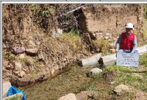
Tomas laterales sin ejecutar, correspondiente al sector de riego Jachitupa Huayanay, sin presencia de personal obrero.
