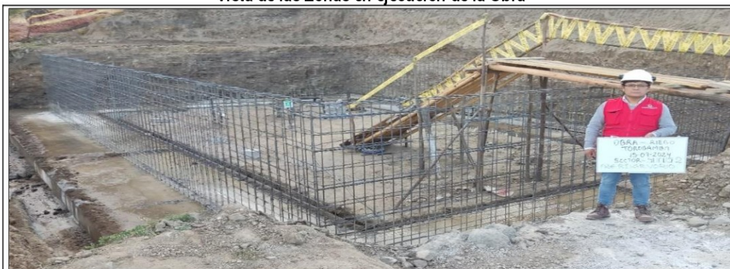
Reservorio de 450 m 3 , a nivel de vaciado de zapata, en un estado de paralizado, sin presencia de personal obrero.
