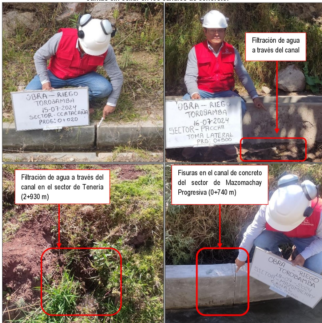
Imagen n.º 9 Juntas sin sellar en los canales de concreto.
