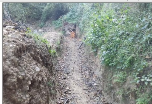
Excavación de zanjas para la construcción del canal de concreto en el sector de riego Socos II, sin presencia de personal obrero.
