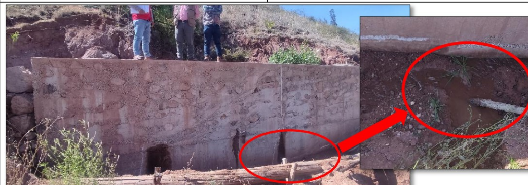
Sector de riego Teneria, el muro de contención de concreto ciclópeo en la progresiva 3+510 m, con presencia de afloración de agua por la cimentación de la estructura.
