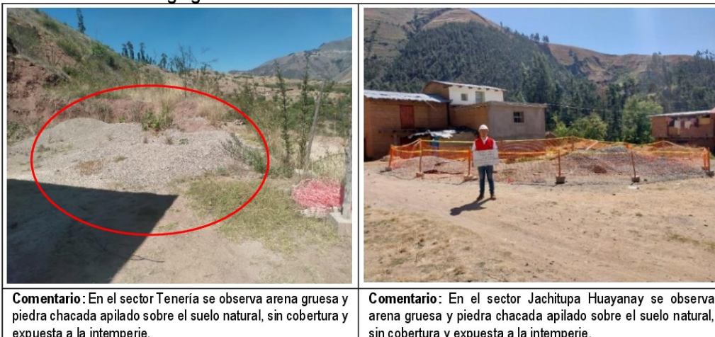
Agregados de construcción almacenados sobre el suelo
