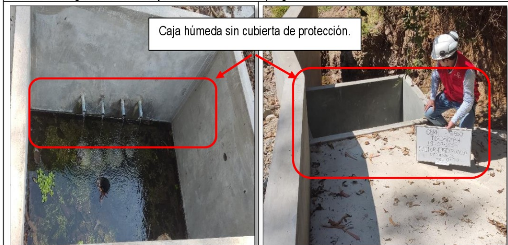
Sector de riego Casaypuquio, se muestra las cámaras húmedas de las captaciones tipo laderra n.º 2, 3 y 5, sin protección.
