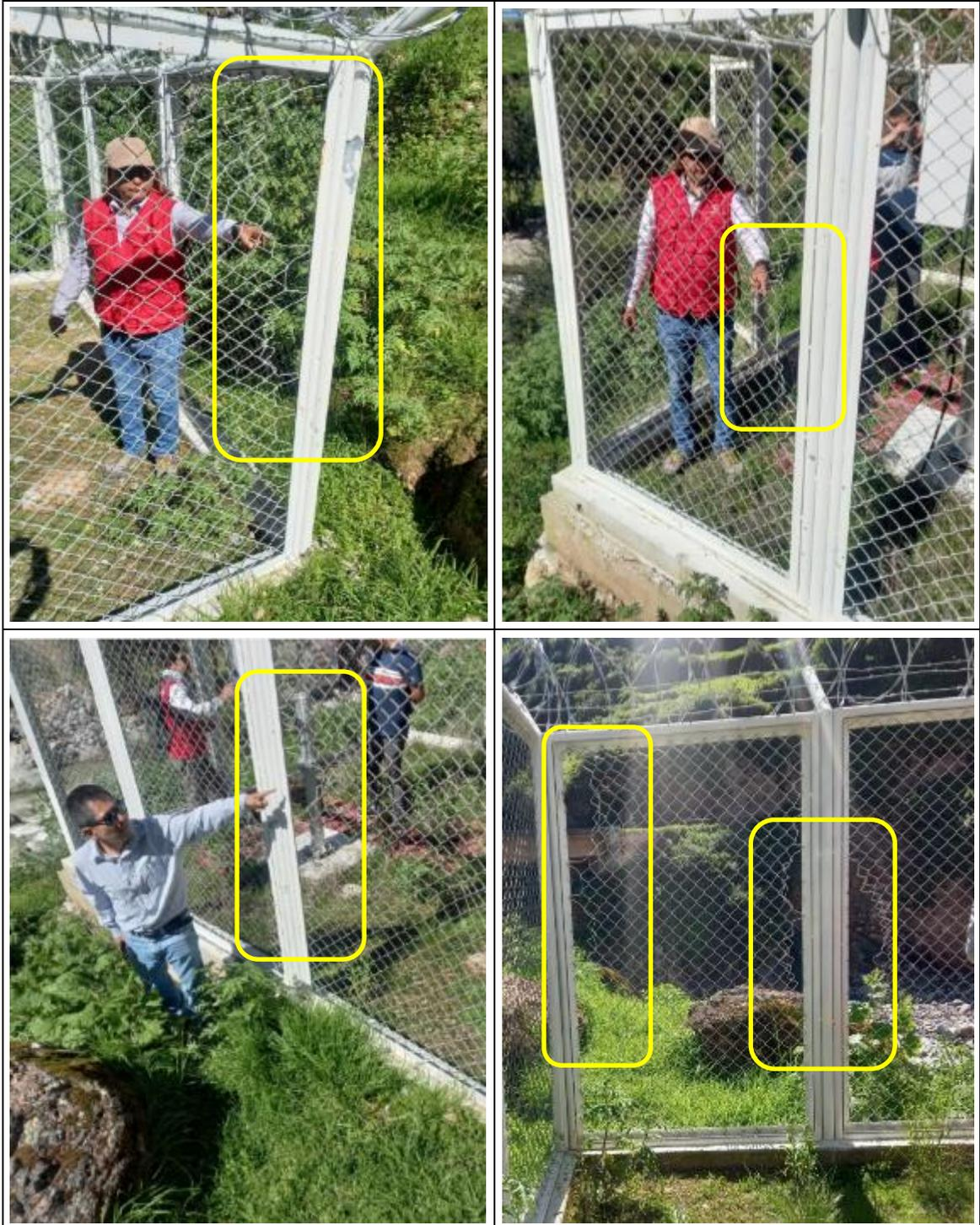
Las imágenes anteriores muestran la ruptura de la malla del cerco perimétrico de la Estación Hidrológica Automática PGIRH-137 “Tambo” Tipo I, evidenciándose piedras al interior del patio de la estación hidrológica, las cuales habrían sido lanzados desde el exterior de la estación, lo cual habría generado daños y abolladuras en los equipos electrónicos instalados, como son el
