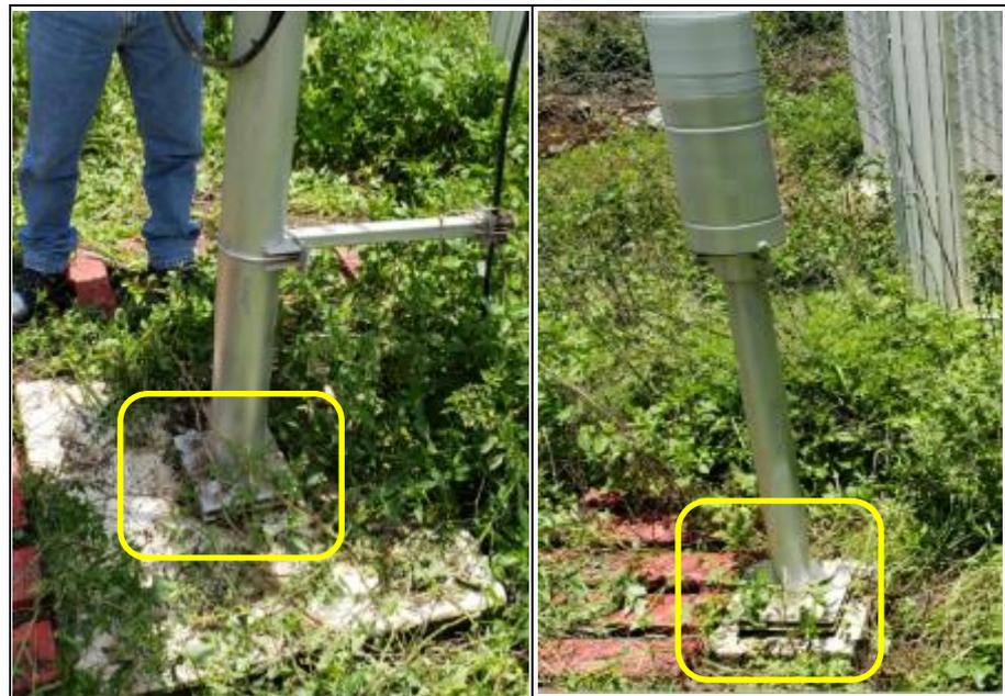
Estructura metálica sin conexión a un sistema de descarga a tierra
