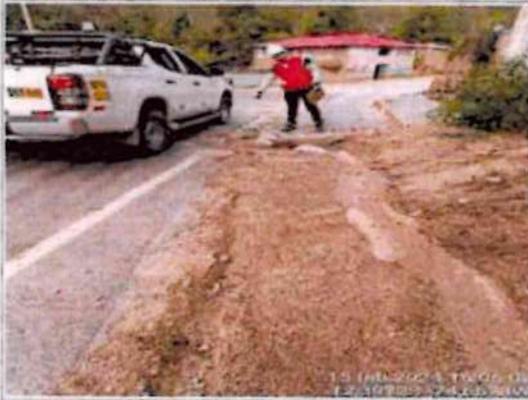
**Comentario:** Se observa en la progresiva Km 9+900 cuneta colmatada y afectando el borde de la calzada.
