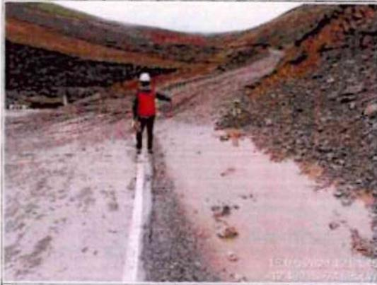
**Comentario:** Se observa en la progresiva Km 3+000 falta de limpieza de calzada, cuneta colmatada, empozamiento de agua y poste de kilometraje sin visibilidad, tapado hasta la mitad aproximadamente.
