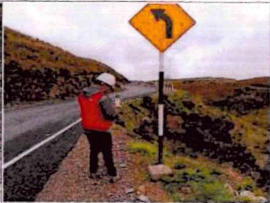
**Comentario:** Se observa en la progresiva Km 3+990 la señal vertical, curva a la izquierda, inestable, propenso a volcadura.
