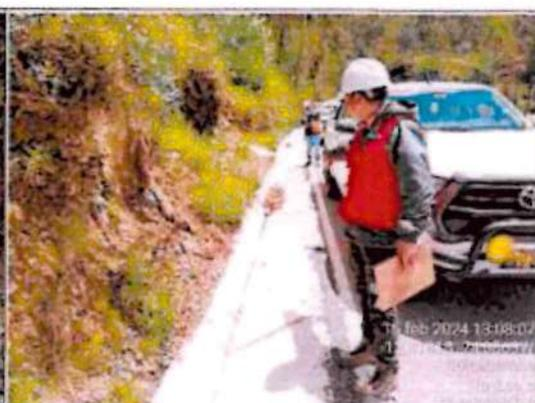
**Comentario:** Se observa en la progresiva Km 14+00 falta de limpieza de las cunetas revestidas.
