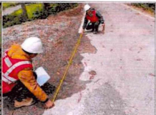
**Comentario:** Se observa en la progresiva Km 11+000 falta de limpieza en la cuneta no revestida.
