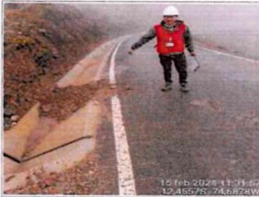
**Comentario:** Se observa en la progresiva Km 0+010 derrumbes, afectando la cuneta revestida.
