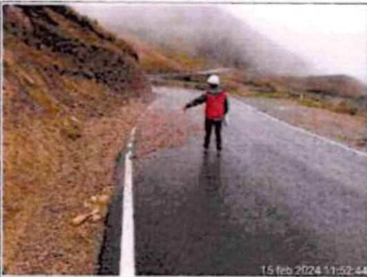
**Comentario:** Se observa en la progresiva Km 1+540 colmatación de cuneta no revestida y falta de limpieza de calzada.
