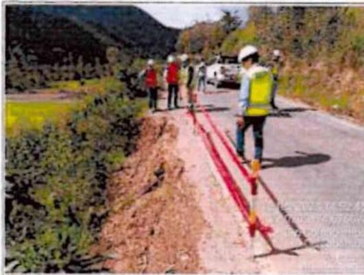
**Comentario:** Se observa en la progresiva Km 0+720 el inicio de la pérdida de la plataforma, generándose una situación de riesgo por el deslizamiento del talud inferior.
