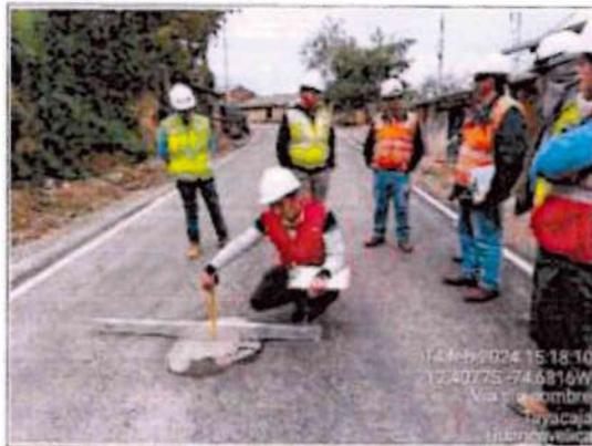
**Comentario:** Se observa en la progresiva Km 25+800 aproximadamente el nivel superior del buzón de inspección de alcantarillado 4cm por debajo del nivel de la superficie de rodadura, asimismo, la tapa del buzón se encuentra tapada parcialmente.
