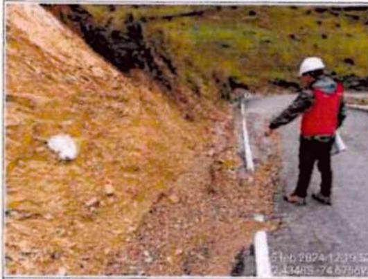
**Comentario:** Se observa en la progresiva Km 5+440 colmatación de cuneta y falta de limpieza de calzada.
