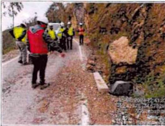
**Comentario:** Se observa en la progresiva Km 9+400 alcantarilla sin pintar, falta de limpieza en calzada.
