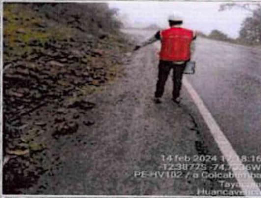
**Comentario:** Se observa en la progresiva Km 7+800 falta de limpieza de cunetas no revestidas
