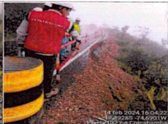
**Comentario:** Se observa en la progresiva Km 22+600 grietas al borde de la plataforma generando una situación de riesgo de deslizamiento del talud inferior.
