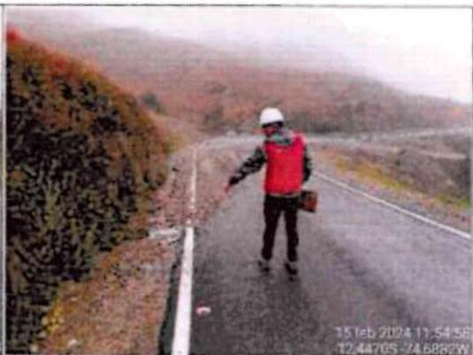
**Comentario:** Se observa en la progresiva Km 1+700 colmatación de cuneta y falta de limpieza de la calzada.
