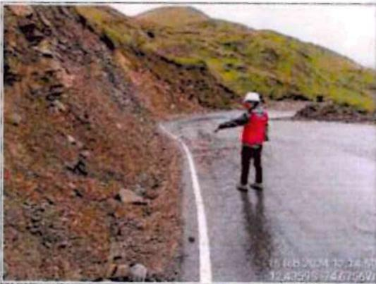
**Comentario:** Se observa en la progresiva Km 4+960 la cuneta colmatada, falta de limpieza de calzada y el poste kilométrico 5+000 no se visualiza correctamente.
