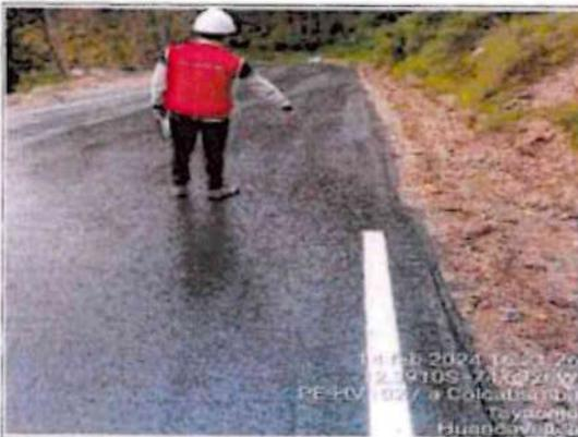
**Comentario:** Se observa en la progresiva Km 21+200 falta de pintura en la línea de borde de la calzada en próximamente 50 m, asimismo, falta de limpieza de la cuneta no revestida.
