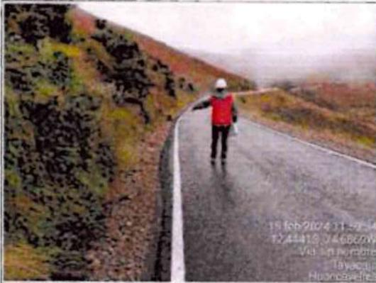
**Comentario:** Se observa en la progresiva Km 2+100 la cuneta colmata con material granular.
