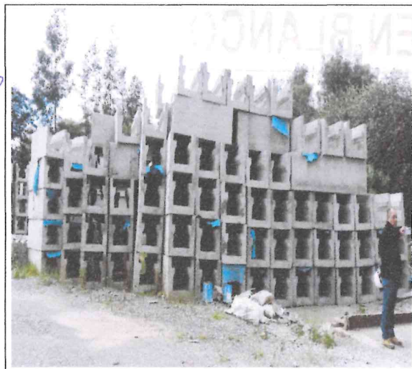
Fotografía 30: Vista de alcantarillas de sección rectangular de longitudes diversas, apilados uno sobre otro, elementos expuestos a la intemperie.
