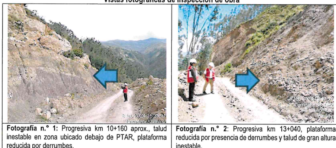
Fotografías n.ºs 1 y 2 Vistas fotográficas de inspección de obra
