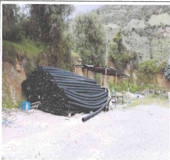
Fotografía 27: Tuberías de pvc corrugadas, apilados expuestos a la intemperie.
