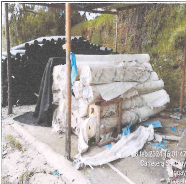
Fotografía 28: Vista de rollos de Malla geotextil apilados, expuestos a la intemperie.
