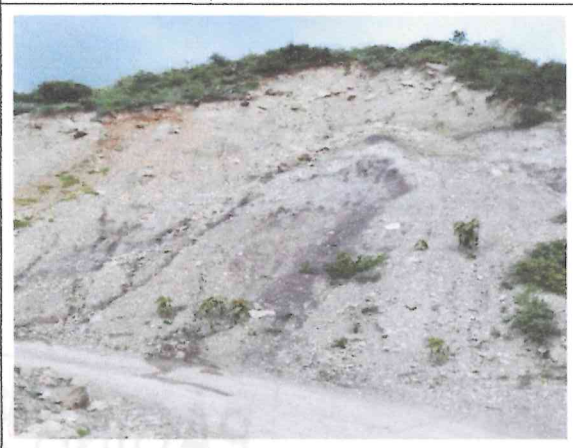
Fotografía 6: Progresiva 10+160 aprox., talud inestable en zona ubicada PTAR, plataforma reducida por derrumbes con filtración de agua en la base.
