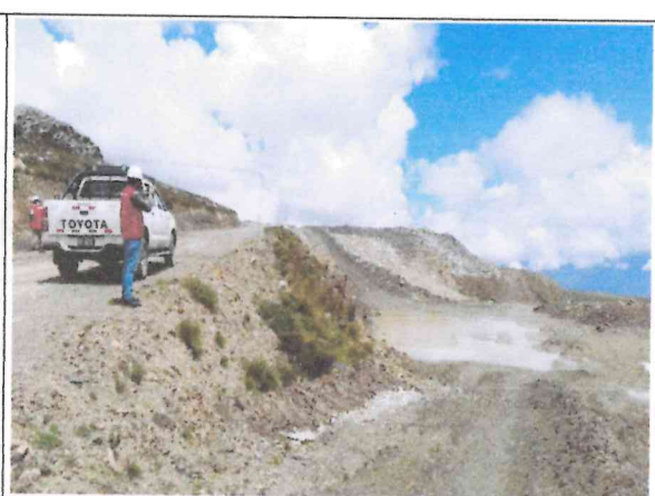
Fotografía 18: Progresiva 22+800 aprox. ubicación de DME 02 Deposito de material excedente, material acumulado sin tratar, presencia agua empozada.
