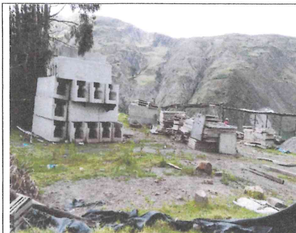
Fotografía 32: Vista de alcantarillas de sección rectangular de longitudes diversas, apilados uno sobre otro, elementos expuestos a la intemperie. En zona de Poncos.
