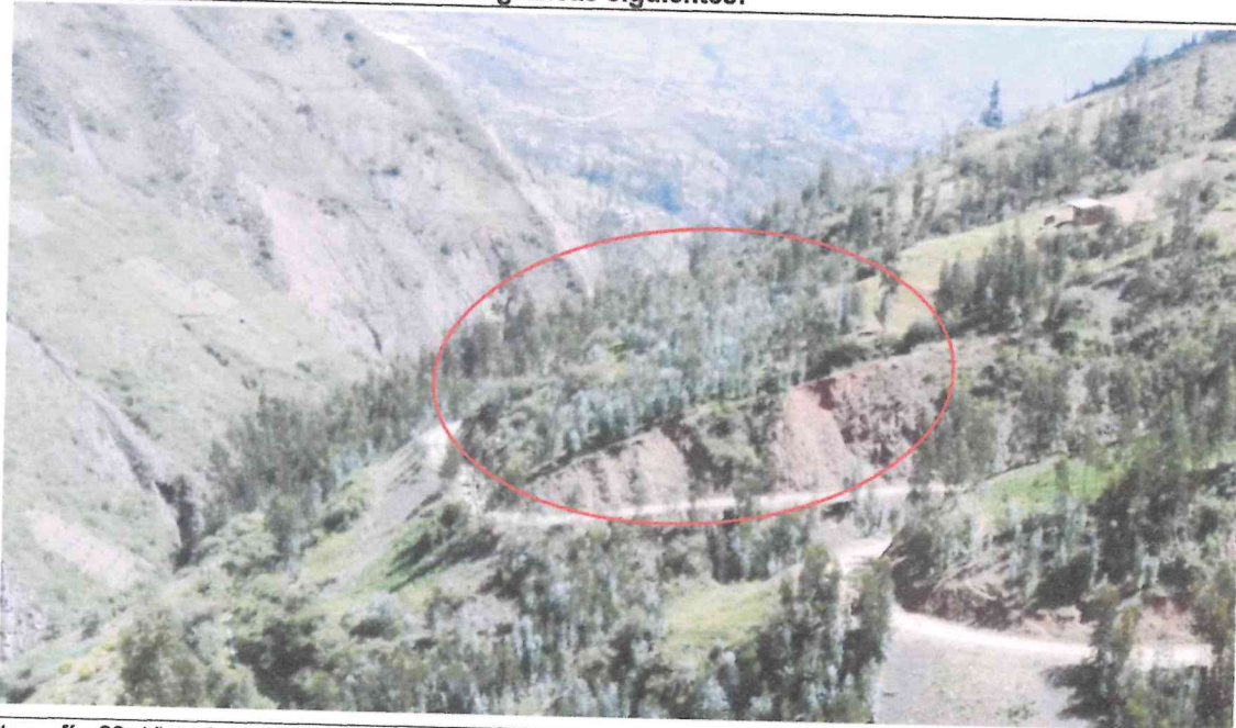
Fotografía 23: Vista fotográfica de ubicación de las nuevas Canteras de afirmado C-08 y C-09 – Progresiva 07+300 aprox., cercano a una vivienda en ladera, asimismo refiere el Ing. Alfonso Ramírez Taipe que cuenta con los estudios y autorizaciones respectivas.
