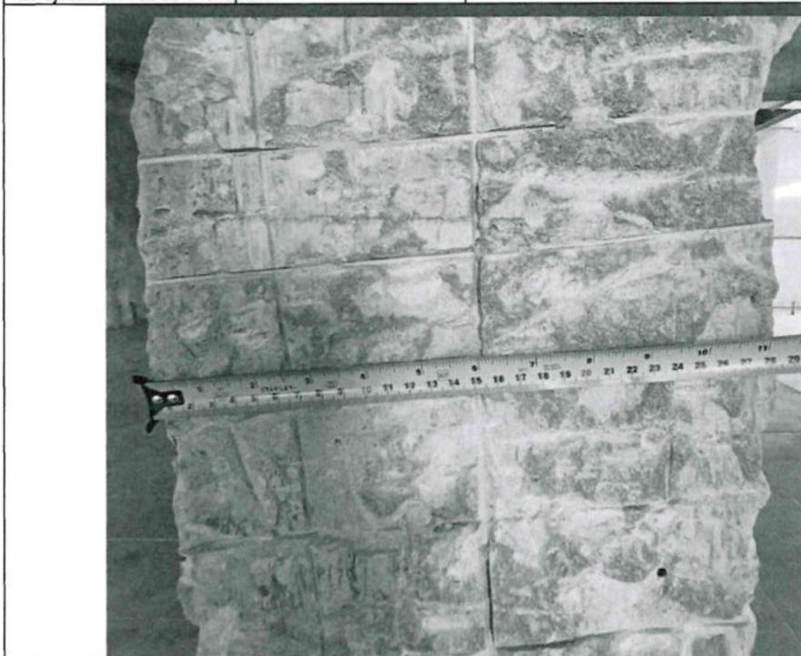
**Fotografía n.º 5:** Se observó que la columna "picada" tiene una medida que van hasta los 28 centímetros.
