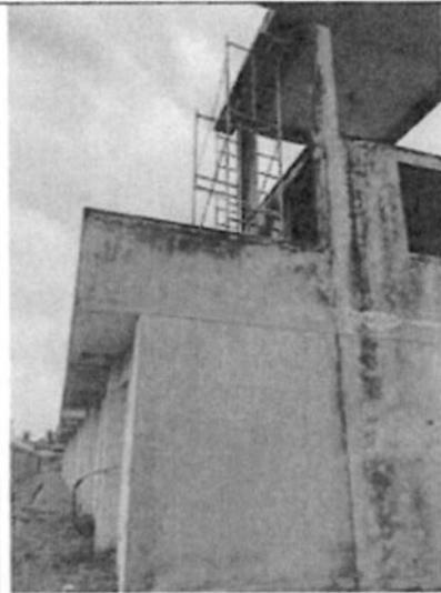
Fotografía n.º 26: Se observó que las paredes exteriores en general cuentan con presencia de moho.
