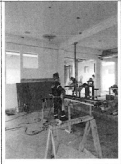
Fotografía n.º 12: se observó una cuadrilla de trabajadores realizando habilitación de rejillas para canaletas pluviales.
