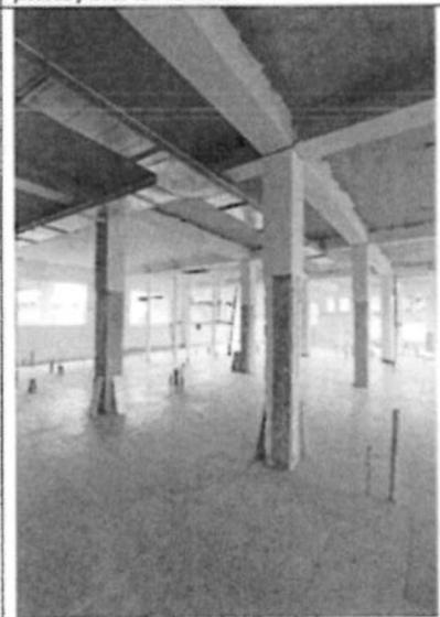
Fotografía n.º 20: Vista de las columnas picadas para luego ser enchapadas con mayólica.
