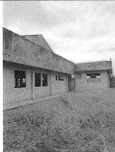
Fotografía n.º 24: Se observó que las paredes exteriores presentan moho.
