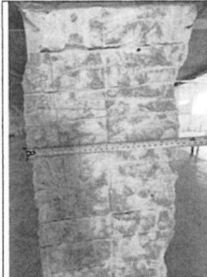
Fotografía n.º 21: Se observó que las columnas picadas presentaban medidas de hasta 28 centímetros de ancho.
