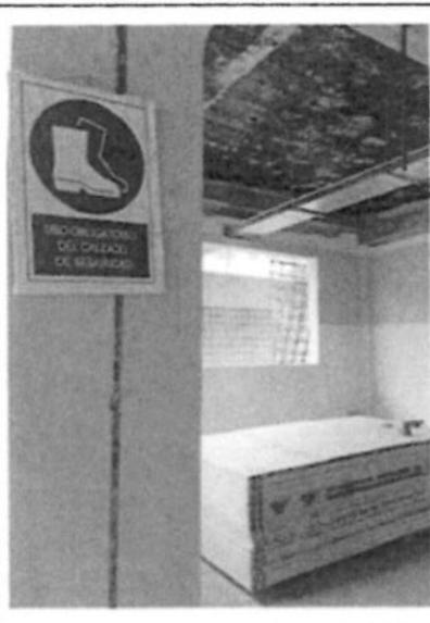
Fotografía n.º 06: Se observó planchas de drywall almacenadas dentro de los ambientes de la obra.
