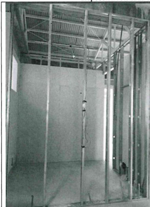
**Fotografía n.º 7:** Se observa que la estructura metálica para divisiones de drywall se encuentran sin culminar.
