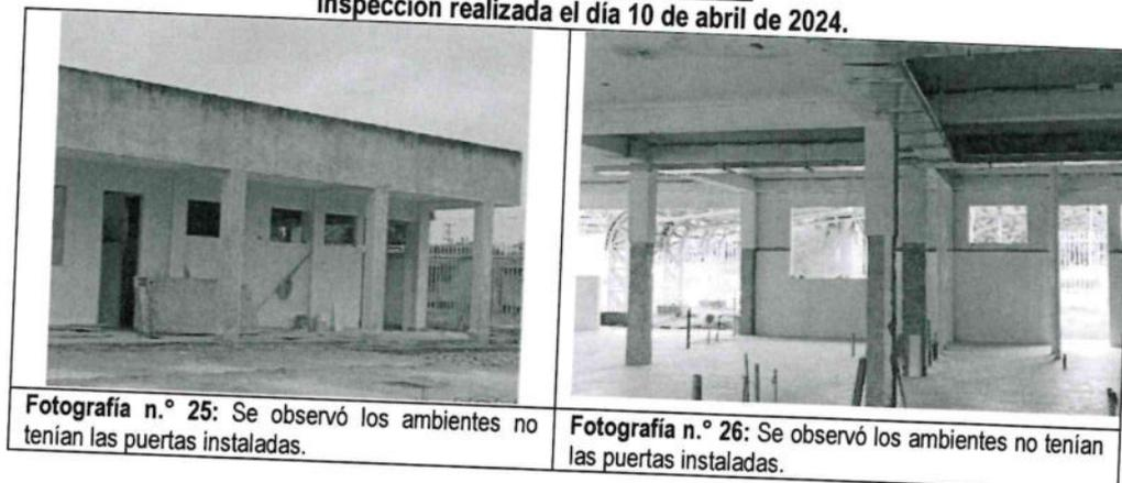
**Fotografía n.º 25:** Se observó los ambientes no tenían las puertas instaladas.
