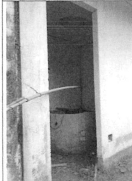
Fotografía n.º 27: Se observó que el contratista viene utilizando agua el pozo, asimismo, el pozo aún no cuenta con tapa.
