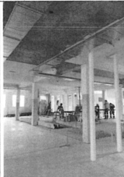
**Fotografía n.º 15:** Se observó que se realizaba trabajos de picado de columnas ya que no correspondía tarrajeo en esas columnas.
