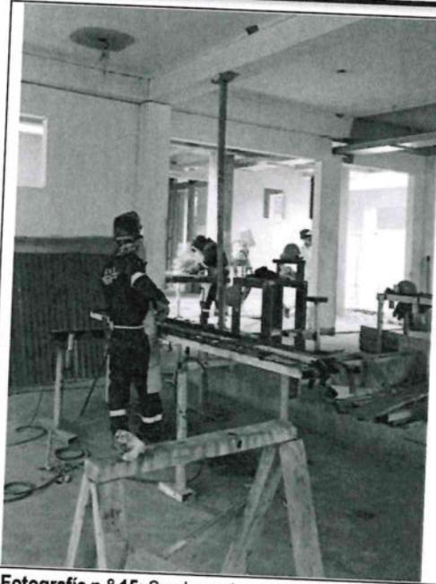
Fotografía n.º 15: Se observó una cuadrilla de personal realizando trabajos de soldadura para tapa de canaletas pluviales.
