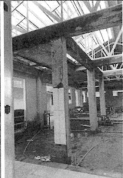
Fotografía n.º 34: Se observó enchapado incompleto en algunas columnas.
