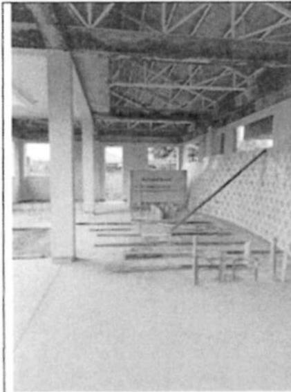
Fotografía n.º 45: Vista general de un módulo con vigas con moho.
