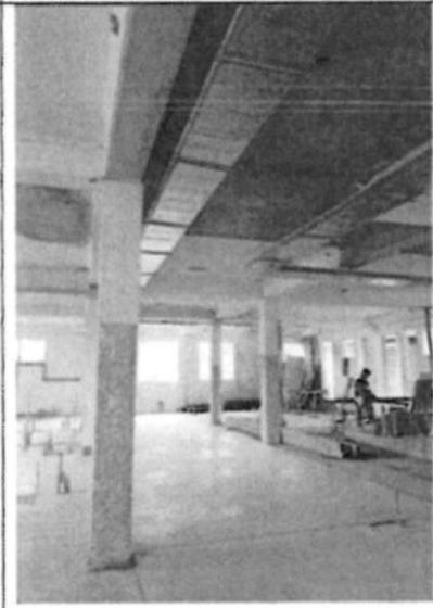
**Fotografía n.º 16:** Se muestra otra vista de las columnas picadas.
