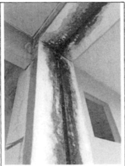
Fotografía n.º 10: Se observó que las columnas y vigas tienen presencia de moho.
