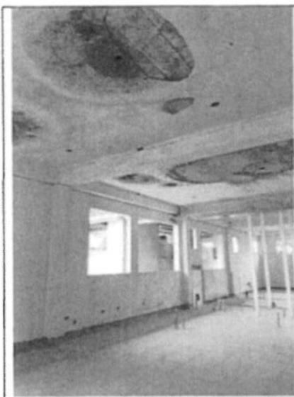
Fotografía n.º 17: Se observó que las losas presentan desprendimiento y humedad.
