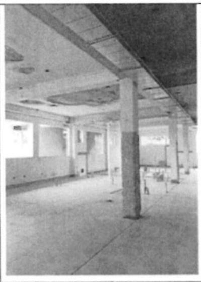
Fotografía n.º 18: Se muestra otra vista de columnas picadas y losas con humedad.
