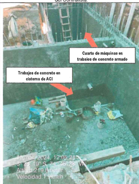
Fotografía n.º 06: Se constató trabajos de concreto armado en Cisterna de Agua Contra Incendios (ACI).
