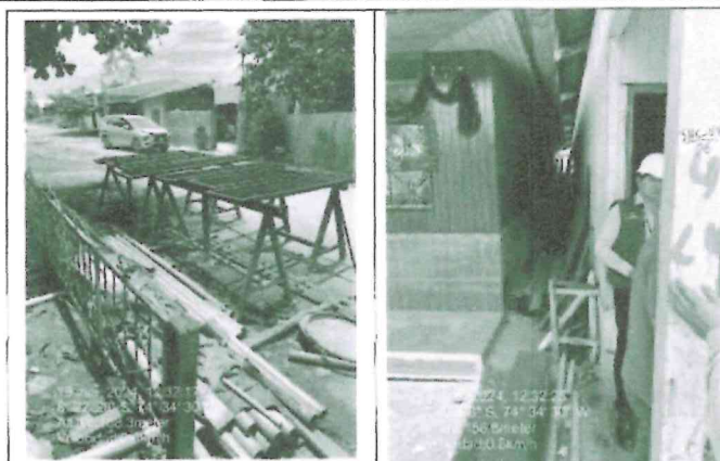
Fotografías n.º 05 y 06: Se realizó la inspección al Almacén de Insumos Metálicos del Contratista ubicado por la Av. La Marina (Shitambari), constatándose perfiles metálicos, tubos galvanizados y 6 rejillas negras.
