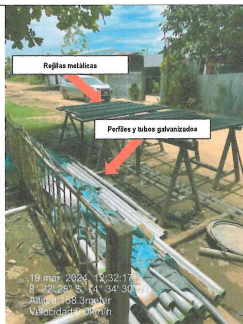
Fotografía n.º 12: Se constató en el almacén externo del Contratista perfiles metálicos y rejillas metálicas que no pertenecen a la Obra.
