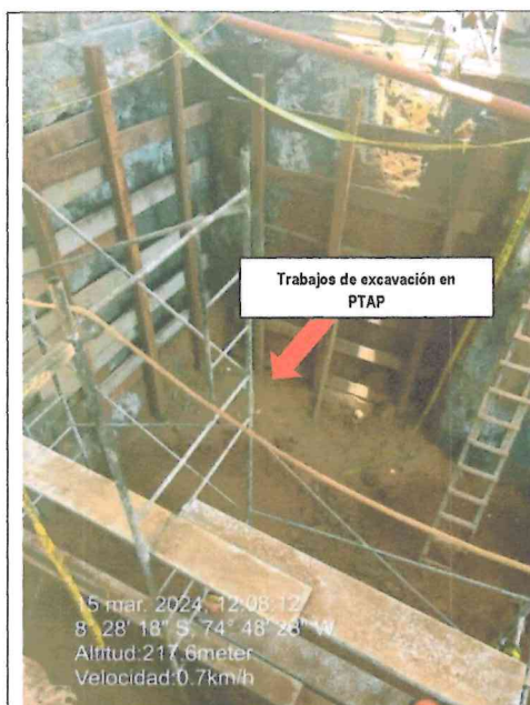
Fotografías n.º 07 y 08: Se constató que se vienen ejecutando trabajos de excavación en la PTAP correspondiente al Adicional de Obra n.º 02 mas no el almacenamiento de los equipos que la componen.
