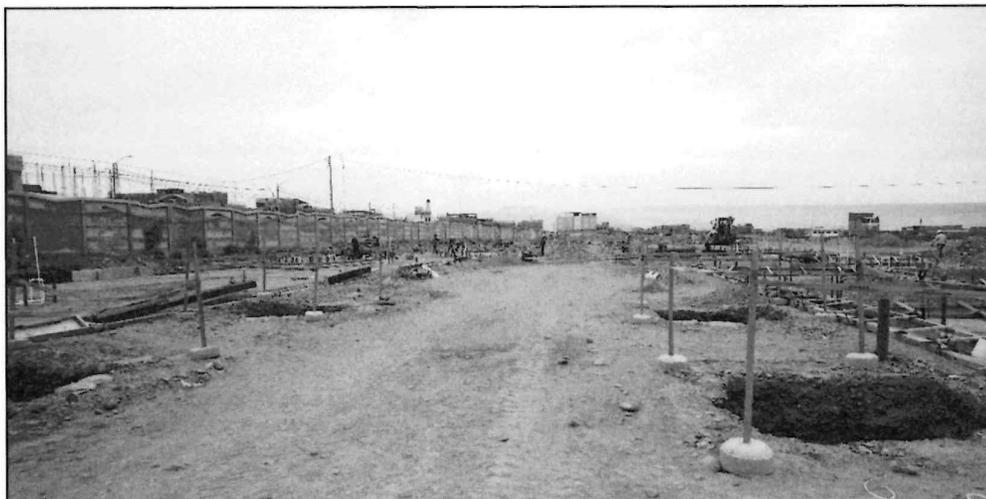
Fotografía n.°1: Se pudo constatar la ejecución de los trabajos correspondientes a la zona de Contingencia. En la imagen se observa el área de Inicial que se encuentra a nivel de excavación y solado para zapatas de las coberturas del patio.
