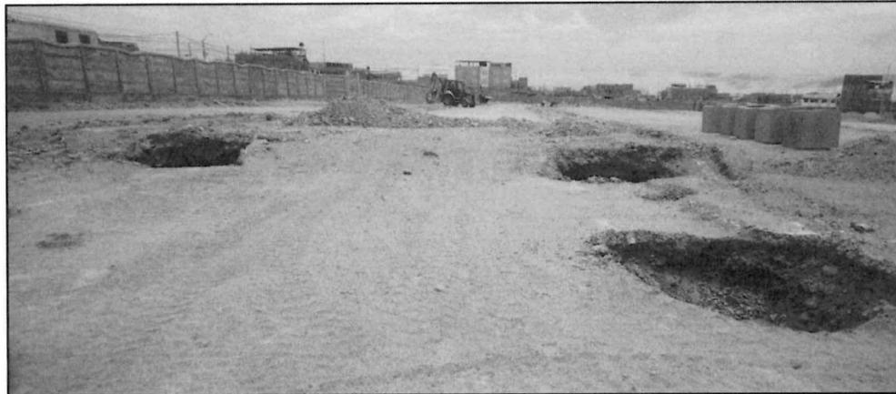
Fotografía n.º 4: En el área de secundaria, se observa que el avance en excavaciones es parcial, con 6 zapatas excavadas al 100% y otras 6 zapatas excavadas parcialmente. Más al fondo, en la zona de Primaria, se puede observar un avance hasta nivelación de terreno y trazo de terreno.
