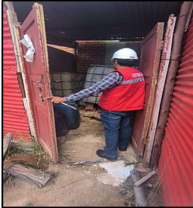
Fuente: Almacenamiento de combustible ubicado en un ambiente inadecuado Elaborado por: Comisión de Control
