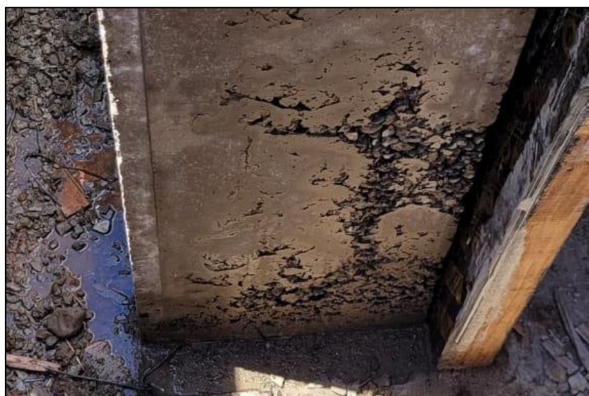
Imagen n.º 4 Cangrejas en la columna C-1 del portón de ingreso vehicular
