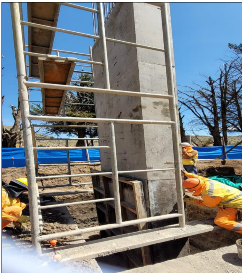
Imagen n.º 4 Cangrejas en la columna C-1 del portón de ingreso vehicular
