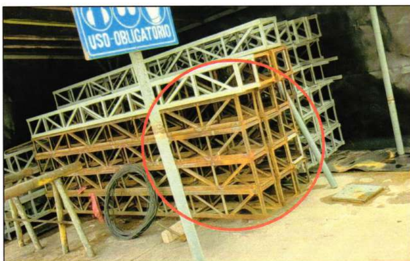
Imagen n.º 08 Estructuras de acero
