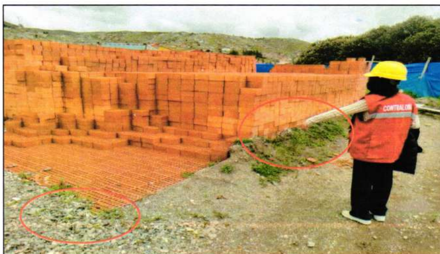
Imagen n.º 10 Unidades de albañilería
