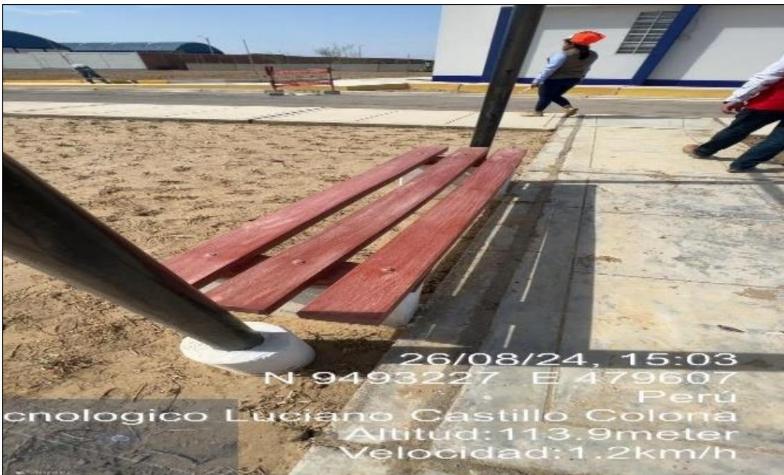
**Fotografía n.º 10: Pintura inconclusa en banca de madera ubicada en las coordenadas UTM N9493227 E479607**
