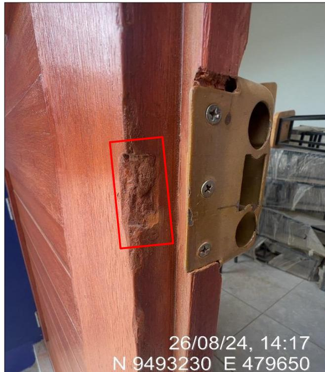
**Fotografía n.º 5: Deficiente acabado en puerta ubicada en las coordenadas UTM N9493230 E479650**
