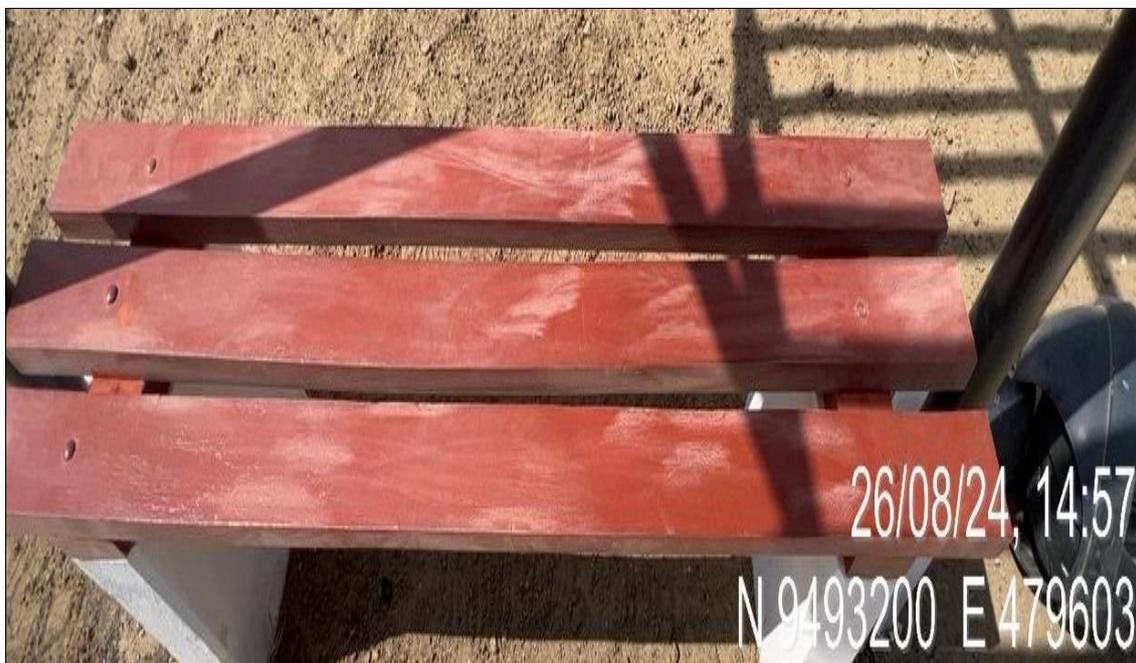
Fotografía n.º 8: Pintura inconclusa en banca de madera ubicada en las coordenadas UTM N9493200 E479603
