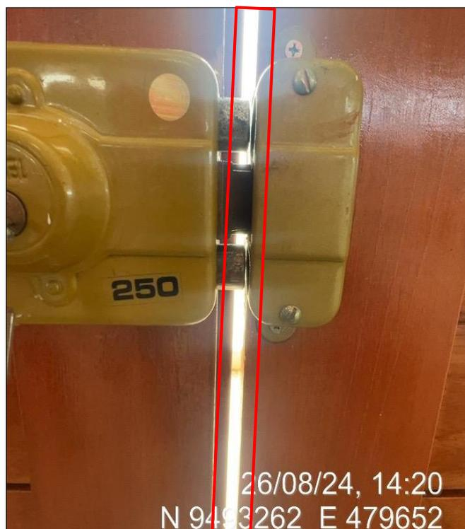
**Fotografía n.º 6: Abertura en puerta doble hoja ubicada en las coordenadas UTM N9493262 E479652**
