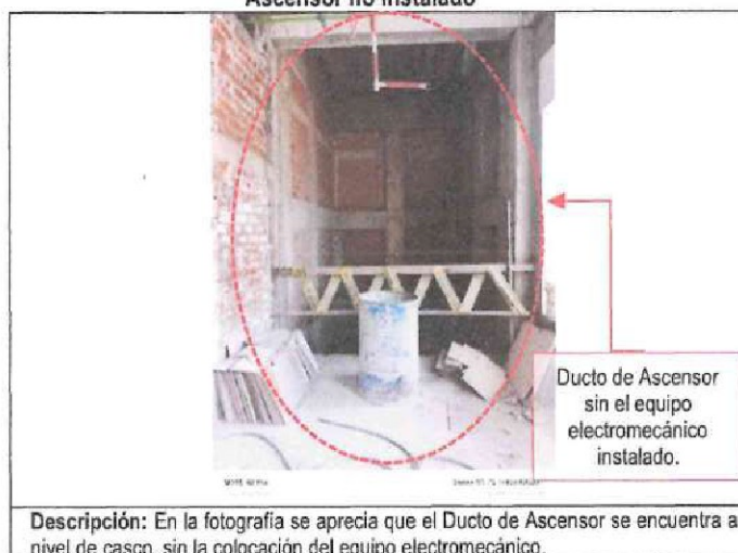
Fotografía n.º 11 Ascensor no instalado
