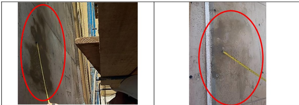
Resanes para cubrir los vacios u oquedades en el concreto en las pantallas de los muros de contención.
