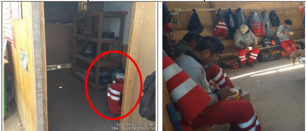
El vestuario de damas no cuenta con piso de cemento (solado) o similar, además no cuenta con casilleros para cada trabajador y viene siendo utilizado como comedor.
