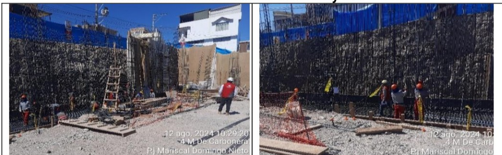
Armado de acero estructural para muros de contención colindantes a la calle Mercedes Cabello de Carbonera.
