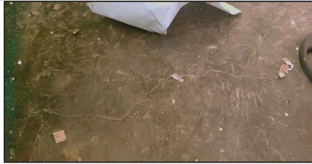
Fisura en Piso de cemento pulido en interior de aula de 3er grado de primaria.
