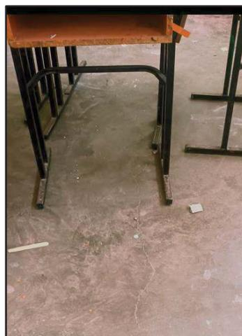
Fisura en Piso de cemento pulido en interior de aula de 2do grado de primaria
