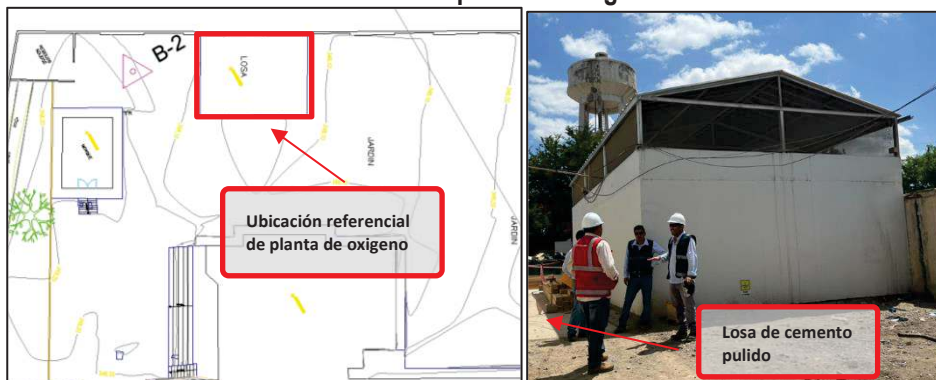
Imagen n.º 8. Ubicación de planta de oxígeno.
