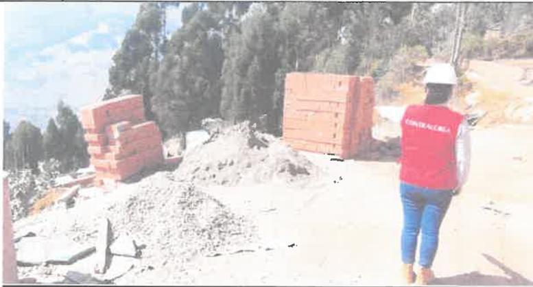
**Imagen n.º 8: Ladrillos y agregados abandonados al exterior de la obra expuestos a la intemperie**
