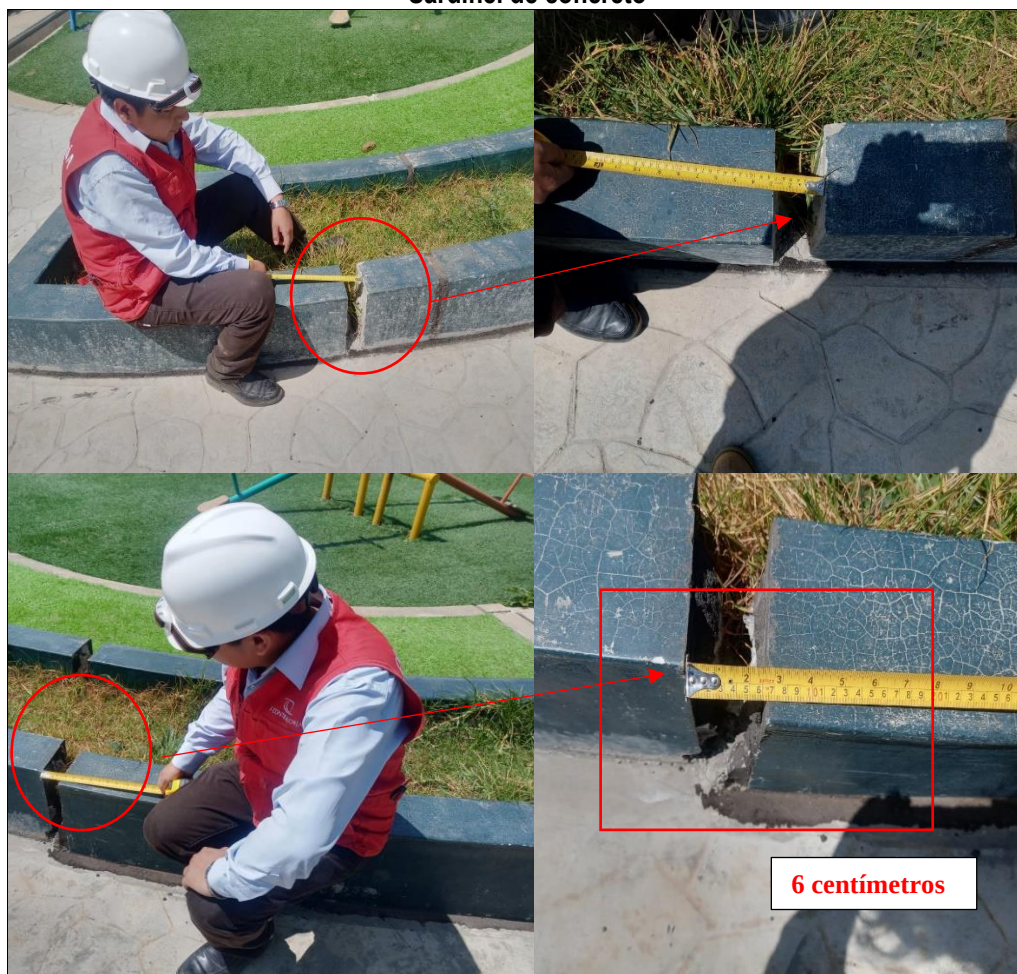
Panel fotográfico n.º 2 Sardinel de concreto
